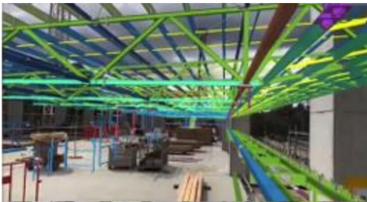
Fig. 02 – Visualização de cobertura metálica
