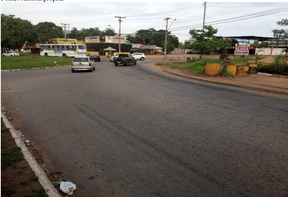
Figura 19. Ausência de sinalização horizontal e vertical na aproximação "C" Guapó- Goiânia Fonte: Autoria própria
