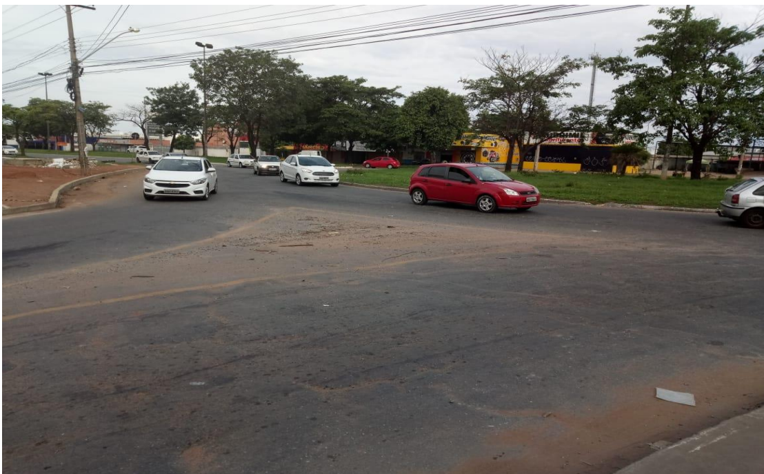
Figura 18. Ausência de sinalização horizontal e vertical na aproximação B da Alameda Câmara Filho Fonte: Autoria própria
