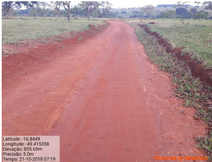
Figura 26. Rebaixamento do Greide.
