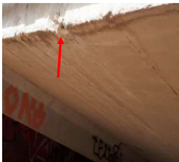
Figura 15 – Face inferior do tabuleiro em 2018. Fonte: AUTORES (2018)
