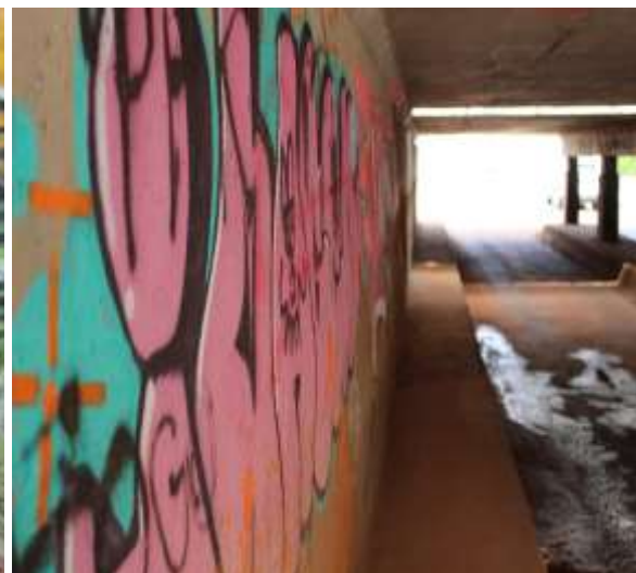
Figura 13 – Lateral do viaduto em 2018. Fonte: AUTORES (2018)
