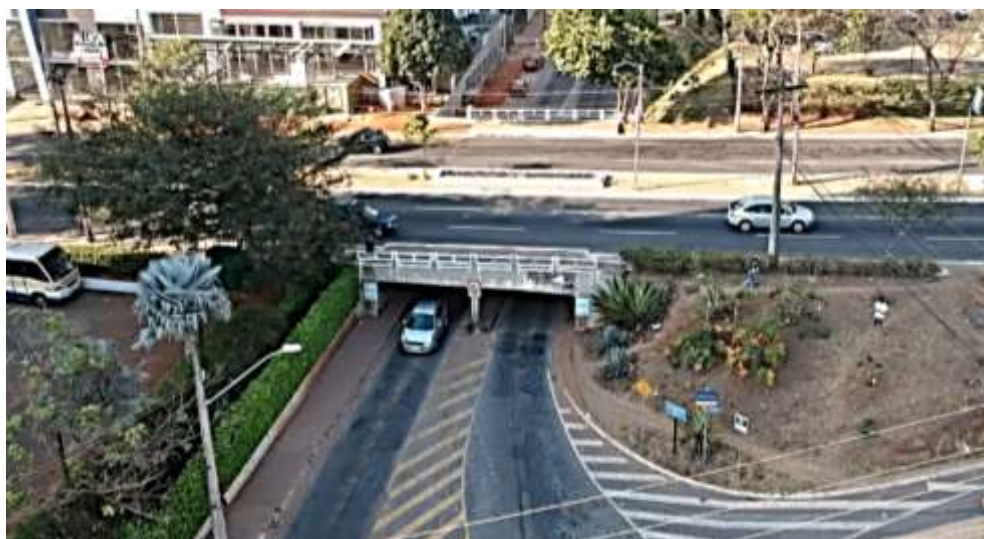
Figura 2 - Vista aérea do viaduto da Avenida H. Fonte: VICTOY (2017)
