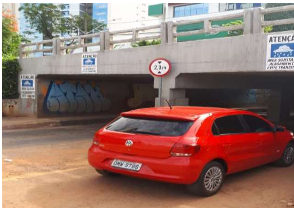
Figura 7 – Vista das placas sinalizadoras no viaduto. Fonte: AUTORES (2018)
