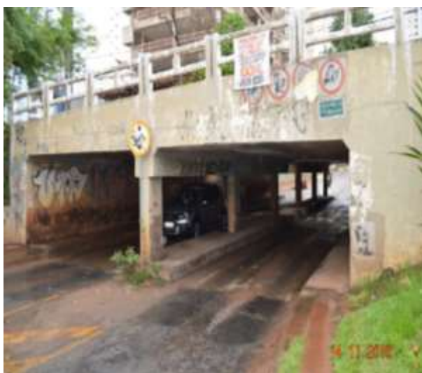
Figura 10 – Vista frontal do viaduto em 2016. Fonte: OLIVEIRA et al (2018)
