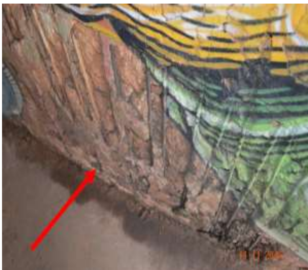
Figura 12 – Lateral do viaduto em 2016. Fonte: OLIVEIRA et al (2016)
