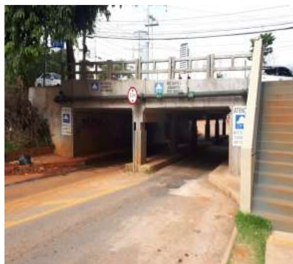
Figura 11 – Vista frontal do viaduto em 2018. Fonte: AUTORES (2018)
