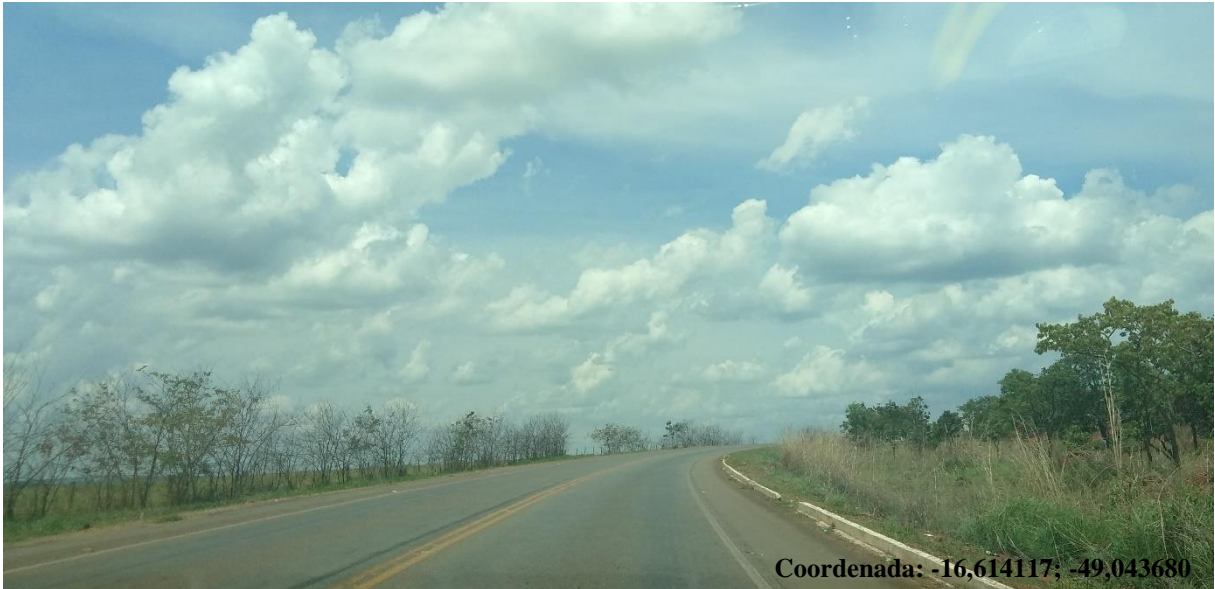
Figura 18. Área 4, curva horizontal sem sinalização vertical na GO 010, Bonfinópolis
