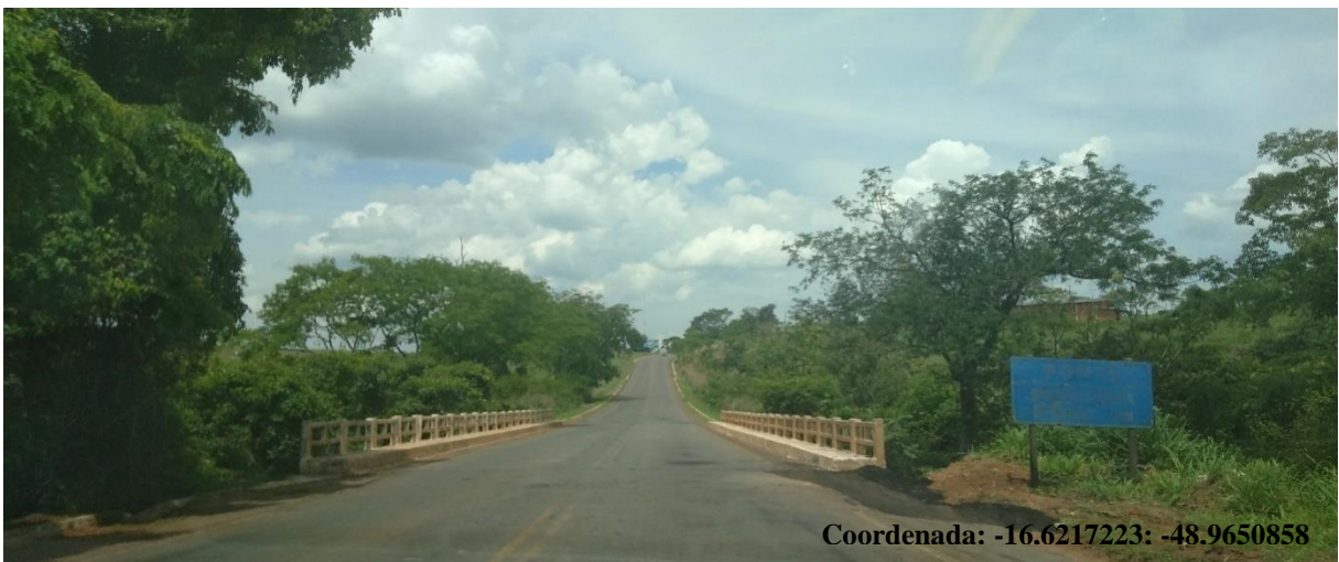
Figura 31. Terceira ponte, sentido Senador Canedo - Bonfinópolis
