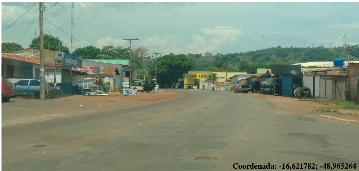
Figura 23. Área 7, curva acentuada sem proteção e sinalização, em zona urbana, Bonfinópolis
