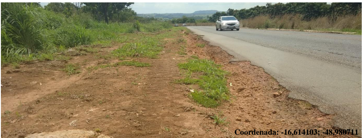
Figura 22. Área 6, fissura no alinhamento do acostamento, Bonfinópolis
