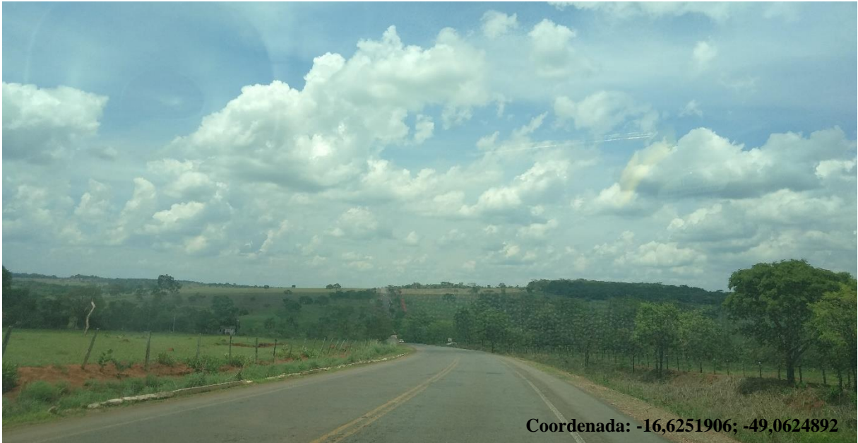
Figura 16. Área 3, curva horizontal seguida de curva vertical na GO 010, Bonfinópolis
