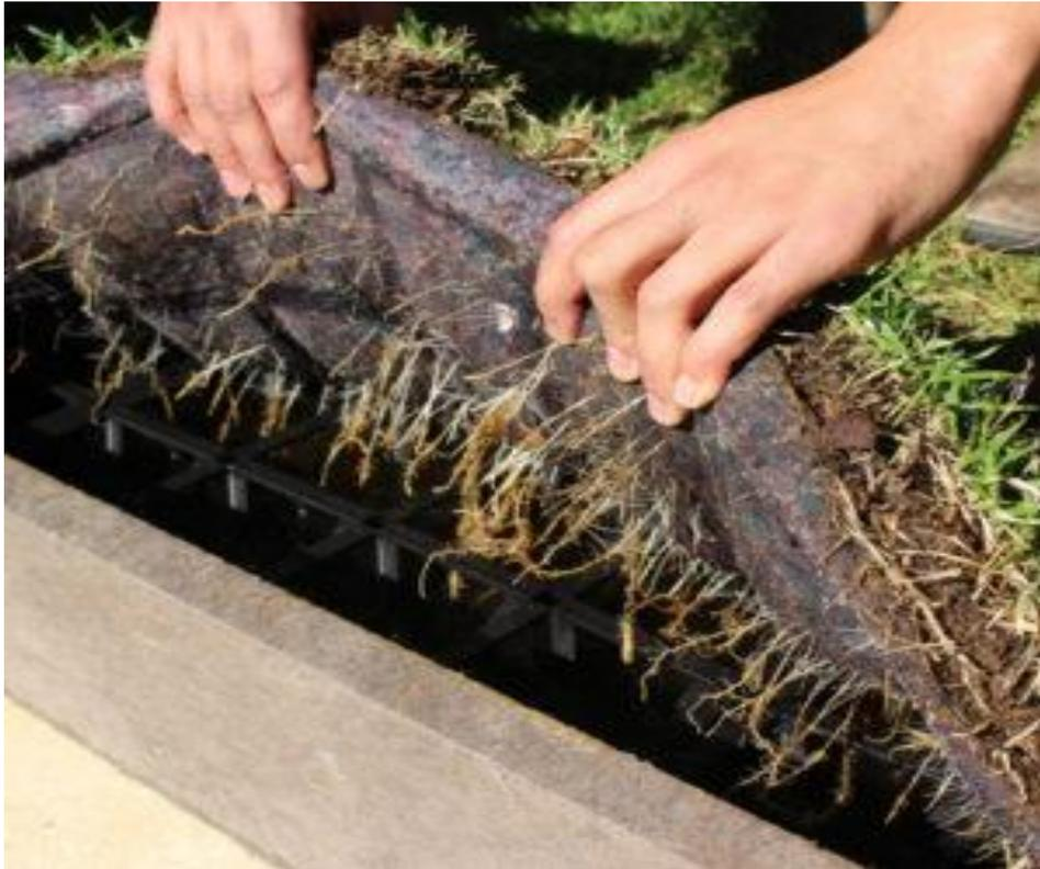
Figura 2. Detalhe interno na cobertura verde.
