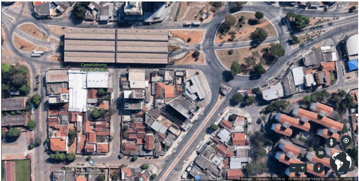
Figura 07: Imagem via satélite da Praça da Bíblia Fonte: GOOGLE EARTH (2018)
