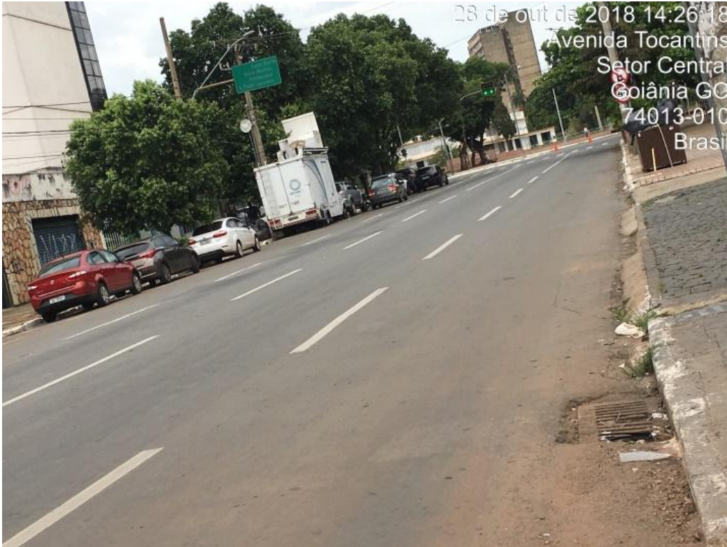
Figura 8 - Sinalização (Avenida Tocantins – Setor Central)
