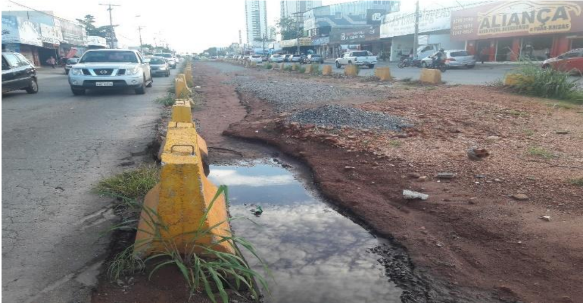
Figura 12: Imagem depois da obra do BRT.
