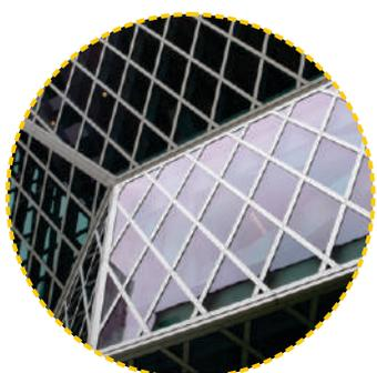
Com a técnica construtiva de laminado de vidro duplo, garante iluminação natural durante o dia, além de compor a fachada com o concreto aparente, integra a edificação à paisagem. Os vidros recebem uma proteção solar que bloqueia grande parte do calor emitido pelos raios solares.
