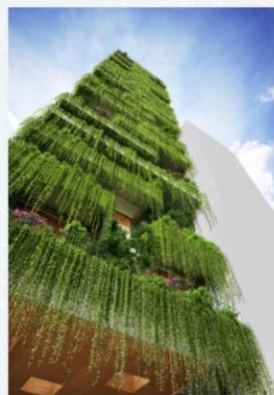
Figura 113: Vegetação nas lajes e sacadas
