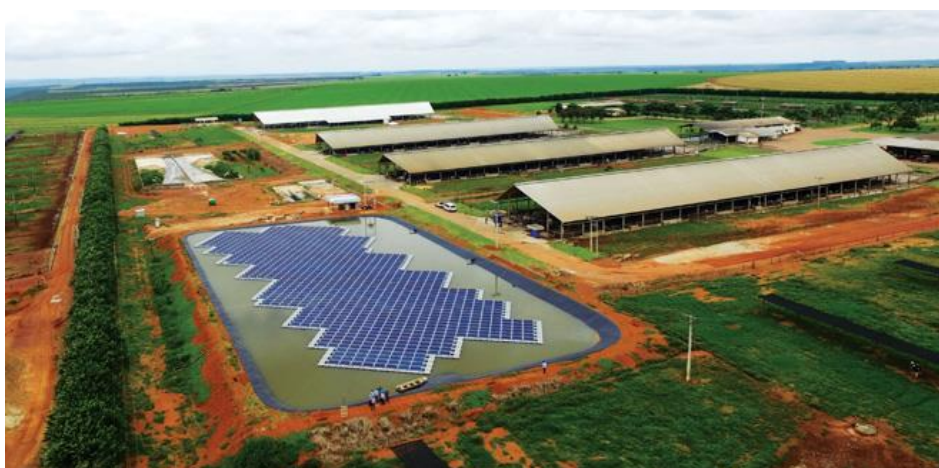
Figura 4. Usina fotovoltaica flutuante na Fazenda Figueiredo, Cristalina – GO.
