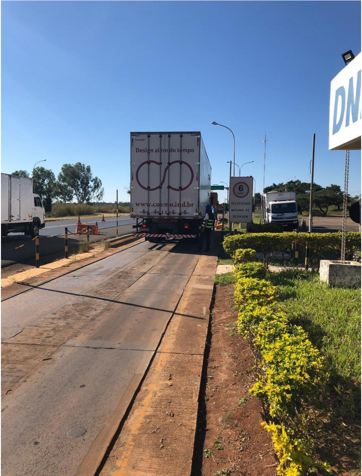
Figura 8: Posto de Pesagem em Formosa – Goiás: Caminhão entrando na balança.
