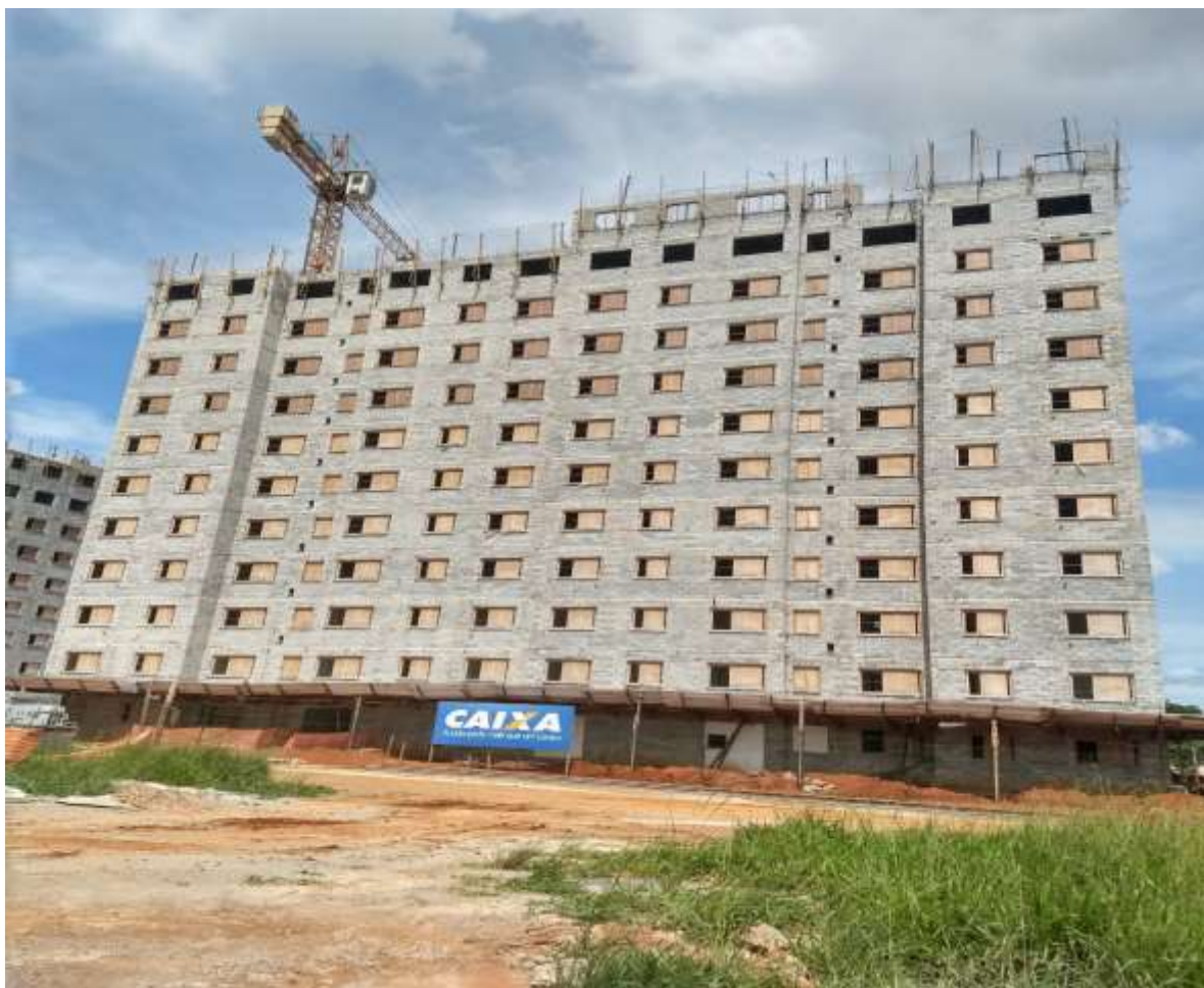
Figura 1.Obra em Alvenaria Estrutural Empresa Parceira
