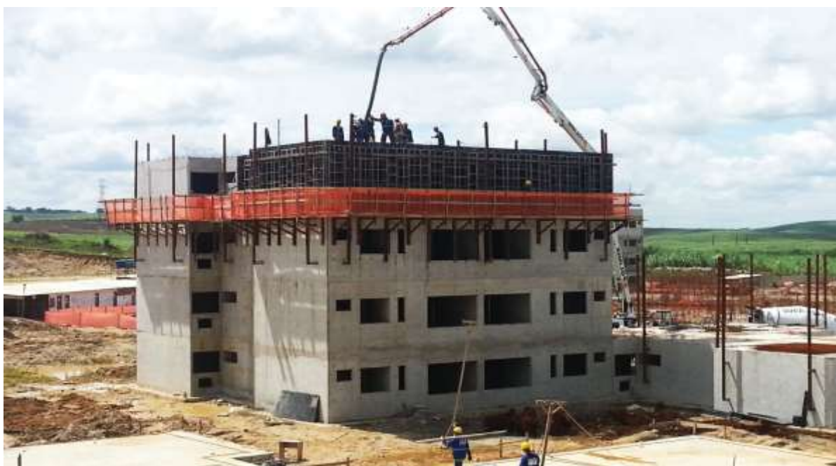
Figura 5. Execução do Sistema em Parede de Concreto Fonte: Sistemas (2016)
