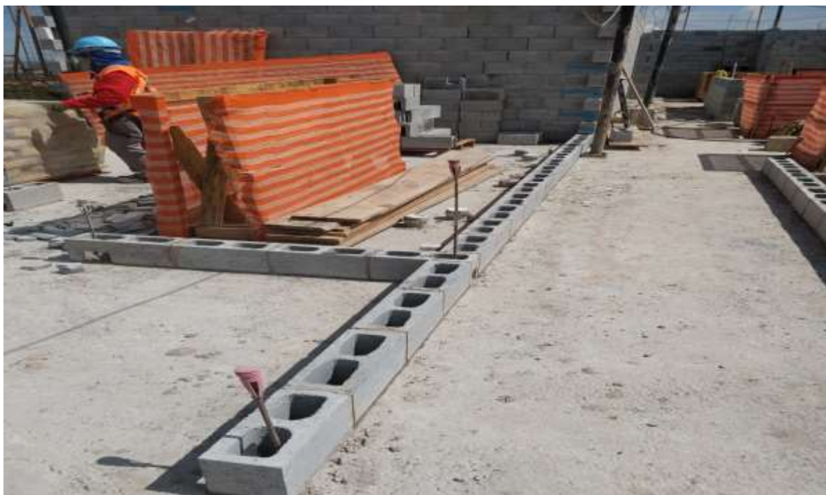
Figura 4. Levantamento da Parede em Alvenaria Estrutural
