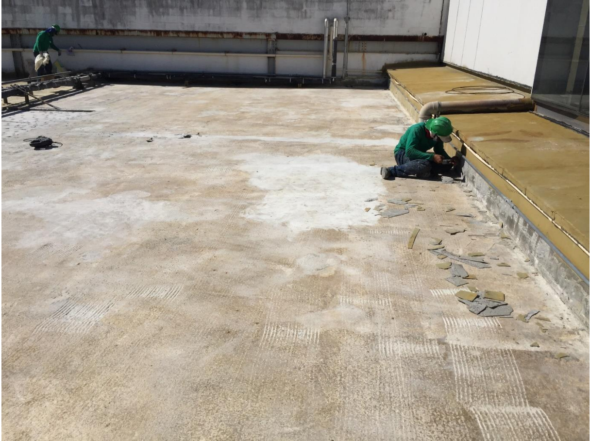
Figura 2. Remoção de impermeabilização existente da laje de cobertura do edifício A.
