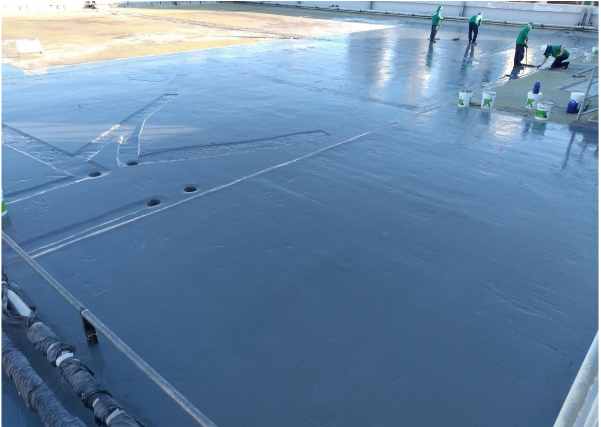
Figura 3. Vista Superior de laje de cobertura com impermeabilização refeita com membrana de poliuretano do edifício A.
