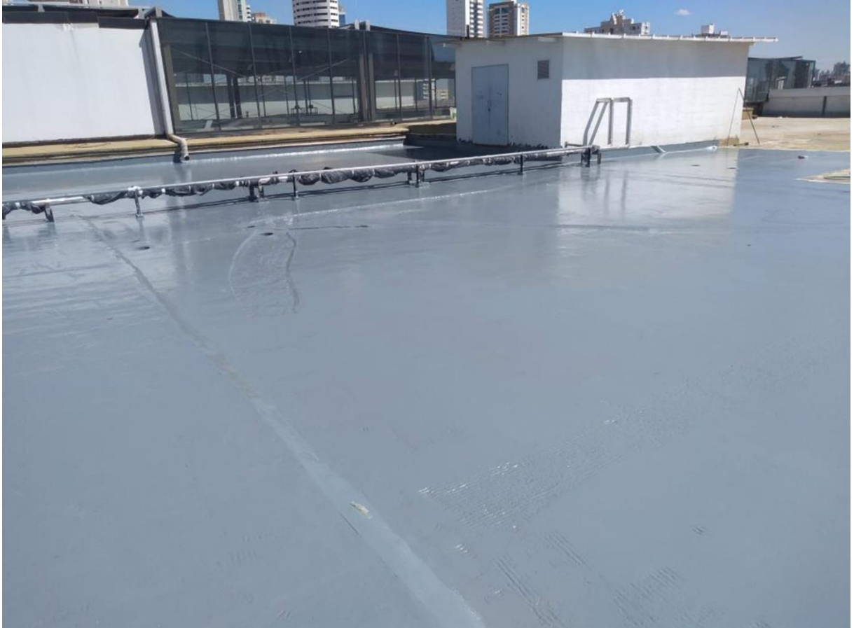
Figura 10. Laje do edifício A impermeabilizada com Membrana de Poliuretano.
