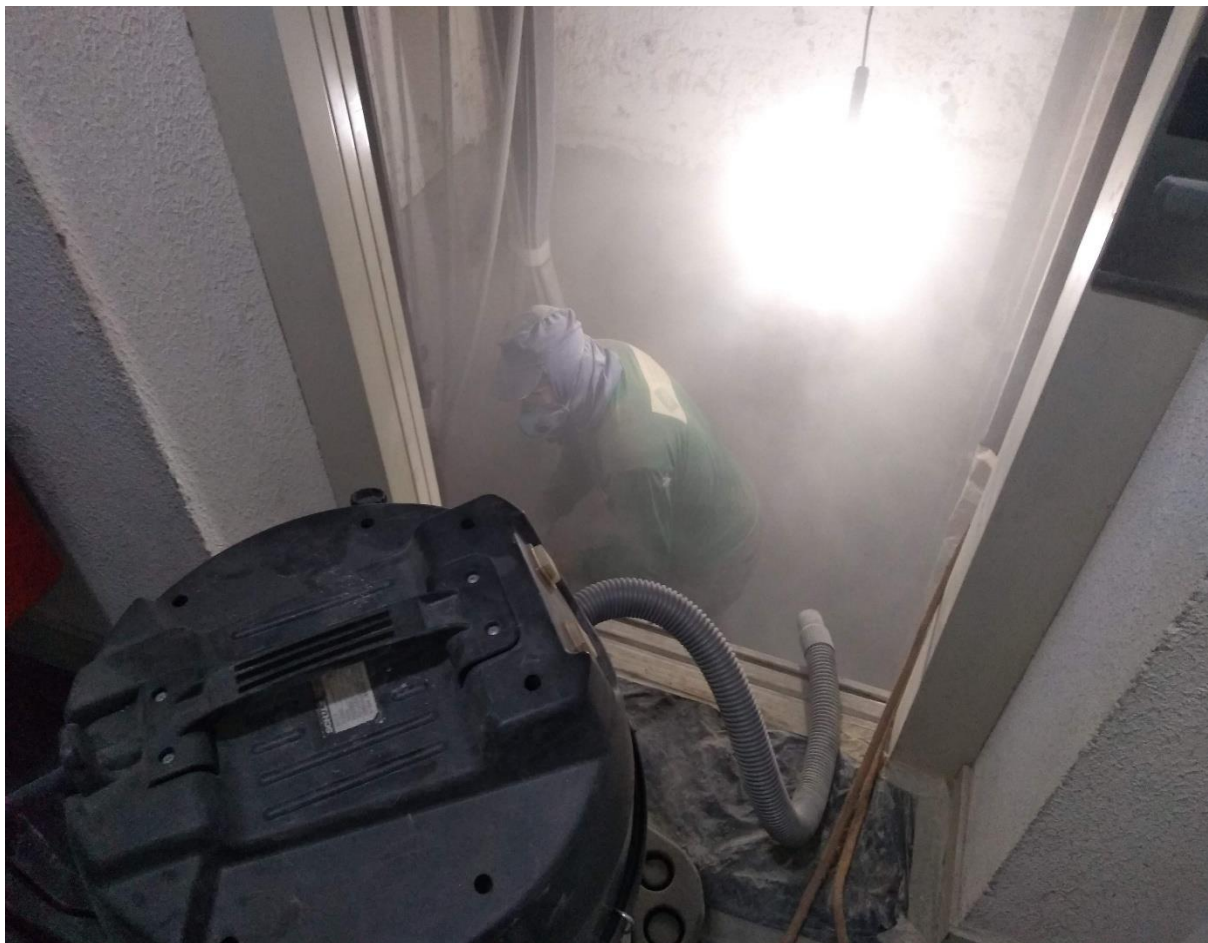
Figura 4. Preparação de superfície interna de poço de elevador em edifício F.
