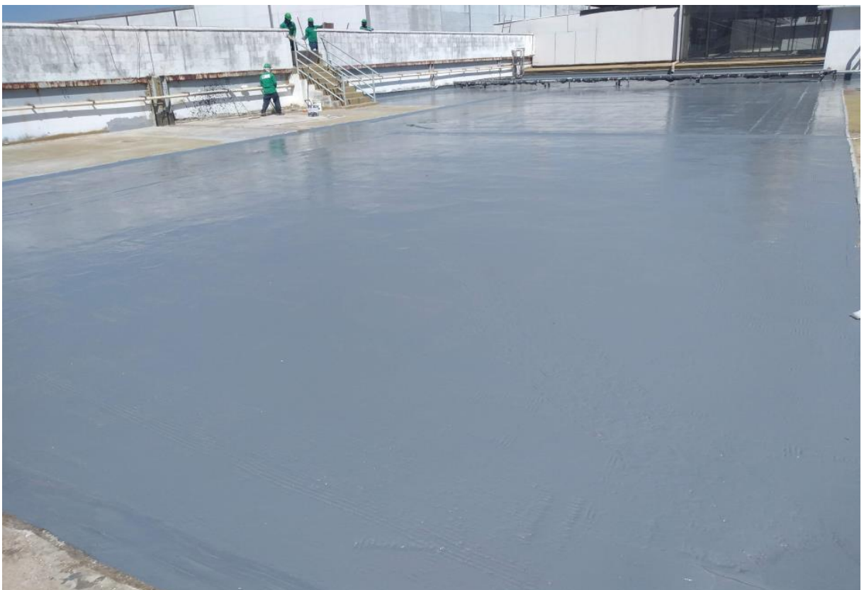
Figura 11. Laje do edifício A impermeabilizada com Membrana de Poliuretano.
