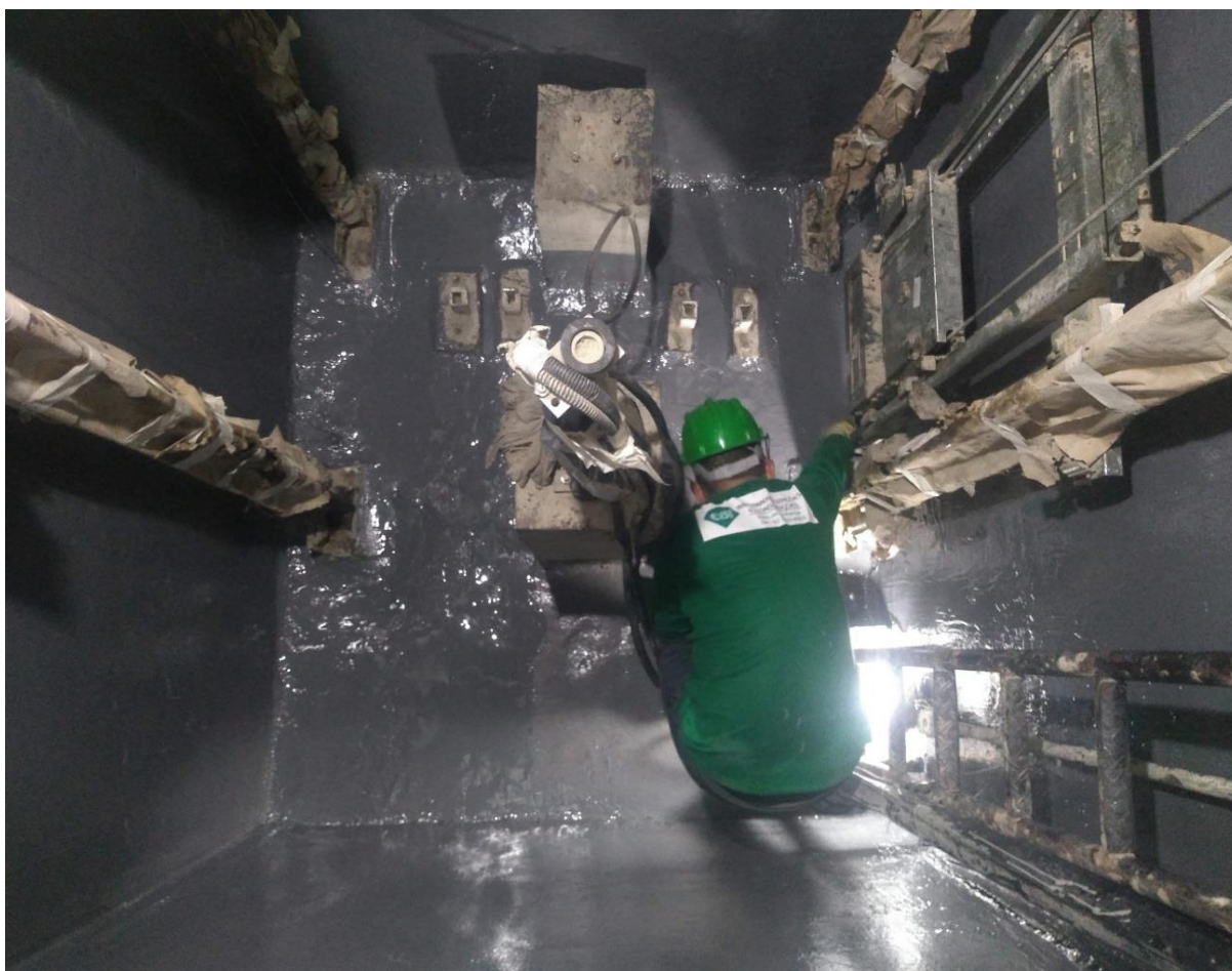
Figura 5. Vista Superior de poço de elevador impermeabilizado com Membrana de Poliuretano no edifício residencial F.
