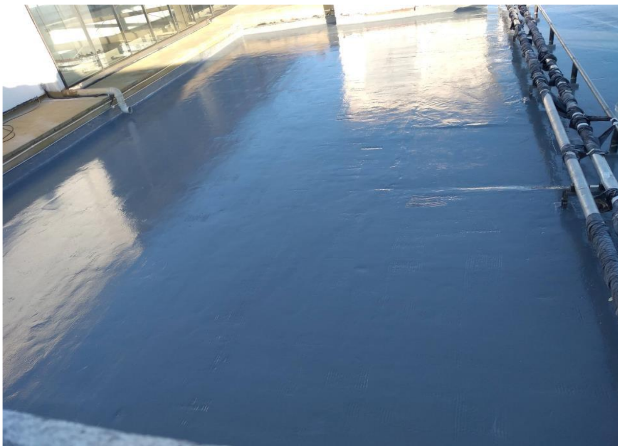
Figura 9. Laje do edifício A impermeabilizada com membrana de poliuretano.
