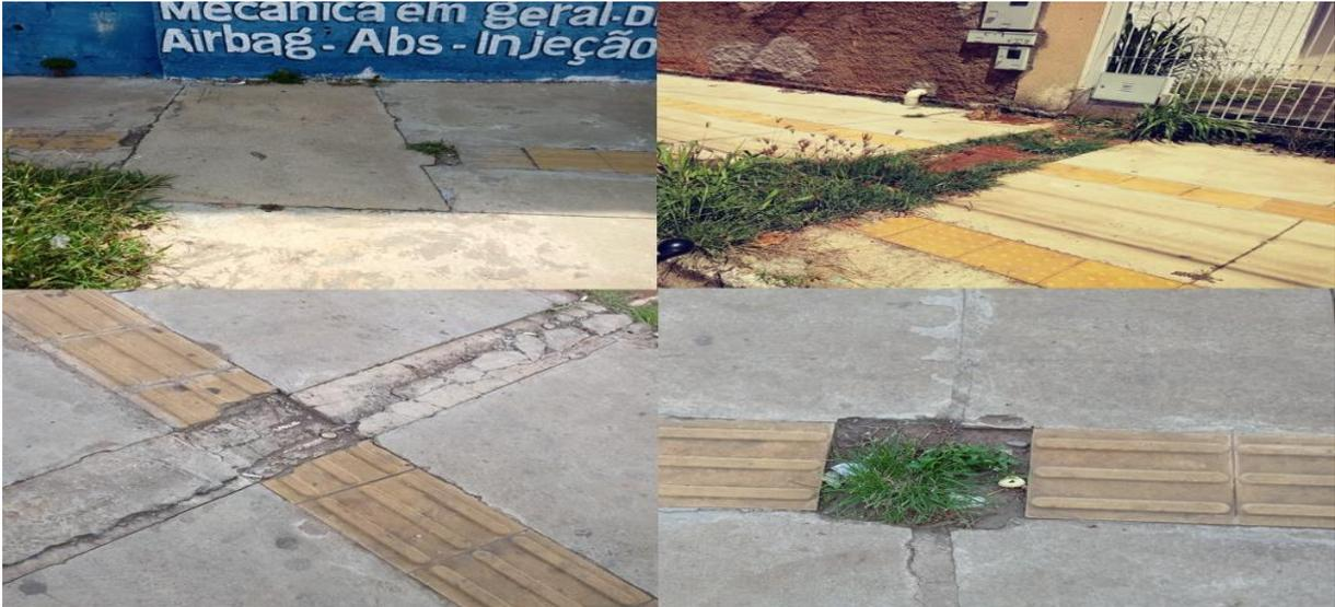
Figura 11: Falta de Manutenção no Piso Tátil.
