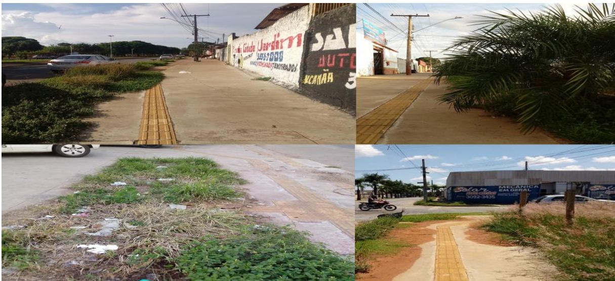
Figura 12: Falta de Manutenção no Paisagismo.
