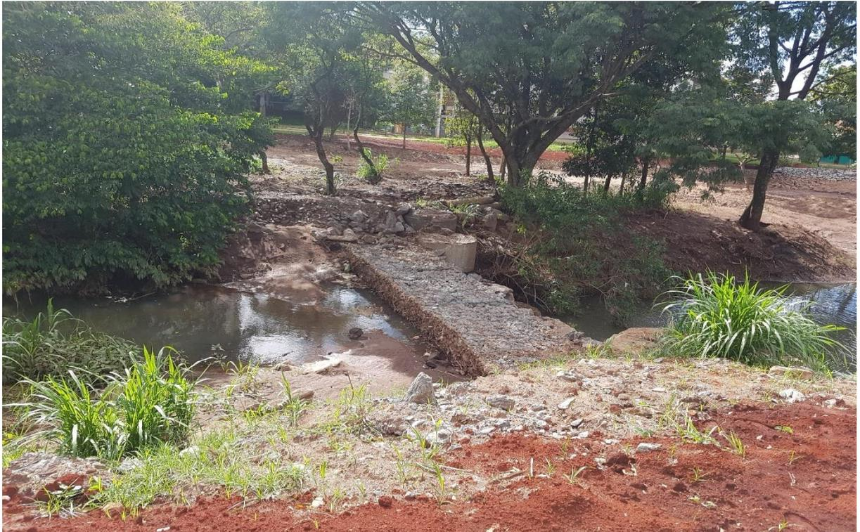
Figura 4. Barramento de contenção e nível com assoreamento acumulado a montante.
