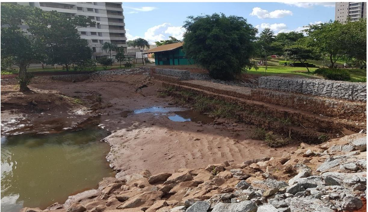
Figura 5. Barramento de contenção com assoreamento aparente.
