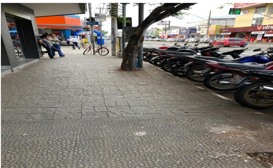
Figura 4: Calçada com 3,15m de largura
