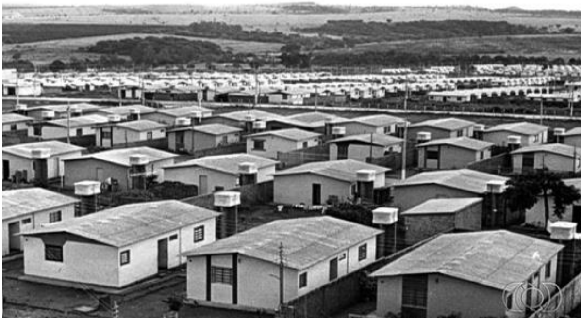
Imagem 26: Residências térreas - 1ª etapa de construção
