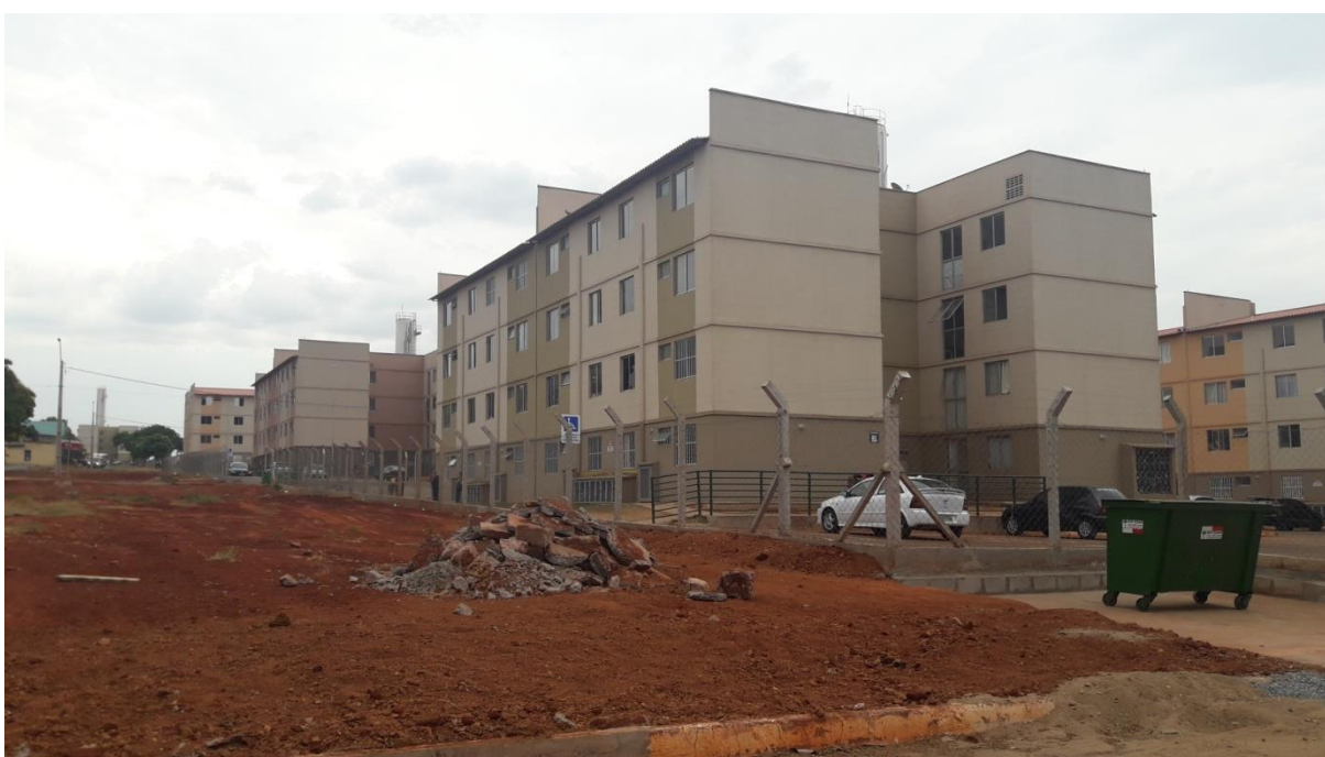
Imagem 41: Residências 4 pavimentos - etapas entregues em 2018 Fonte: Ademir Sperandio Junior (2018)
