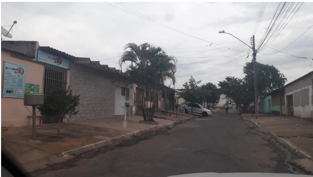
Imagem 40: Residências térreas - etapas iniciais Fonte: Ademir Sperandio Junior (2018)
