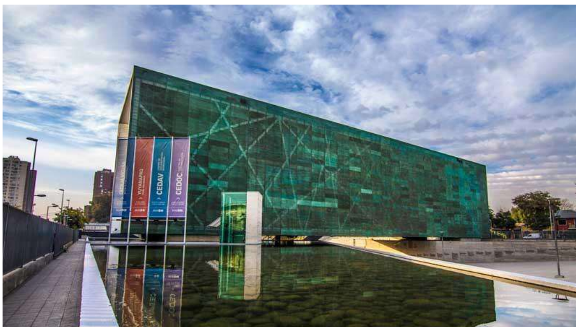
Figura 18: Edifício museu da memória.
