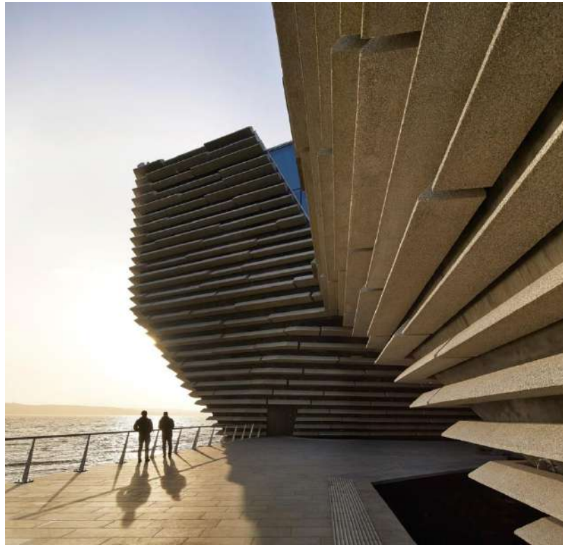
Figura 15: Painéis de concreto.
