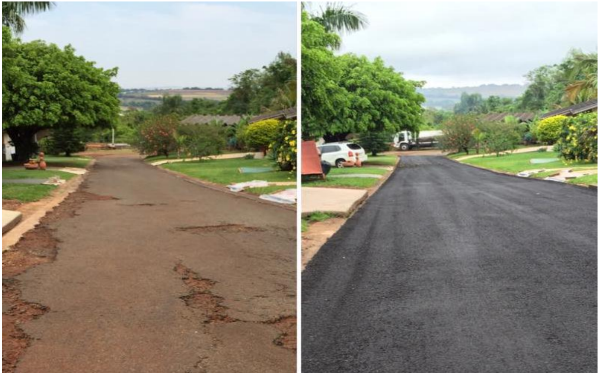
Figura 5. Microrrevestimento asfáltico a frio em Londrina-PR. Fonte: :< https://www.asfaltopav.com.br/microrrevestimento-asfaltico/ >.
