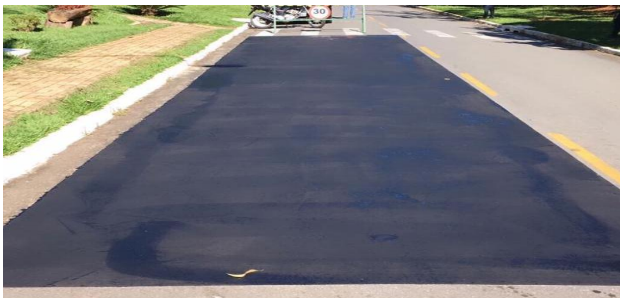
Figura 4. Pavimento asfáltico após a aplicação do TL-2000.
