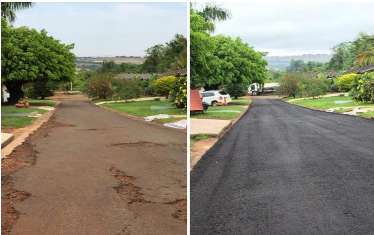
Figura 5. Microrrevestimento asfáltico a frio em Londrina-PR.
