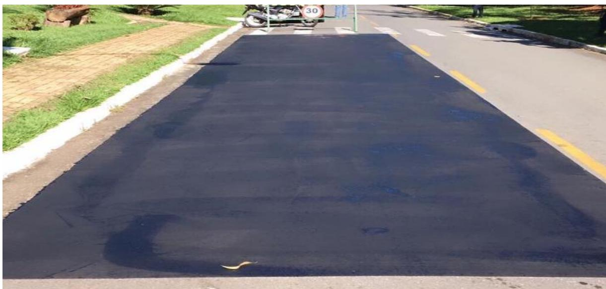
Figura 4. Pavimento asfáltico após a aplicação do TL-2000.
