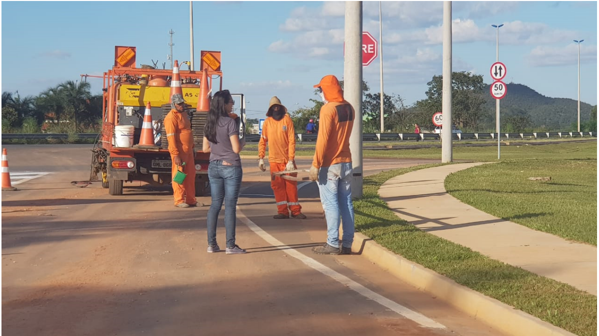
Figura 14: Operários pintando as faixas na via, trecho Goiânia a Bonfinópolis.
