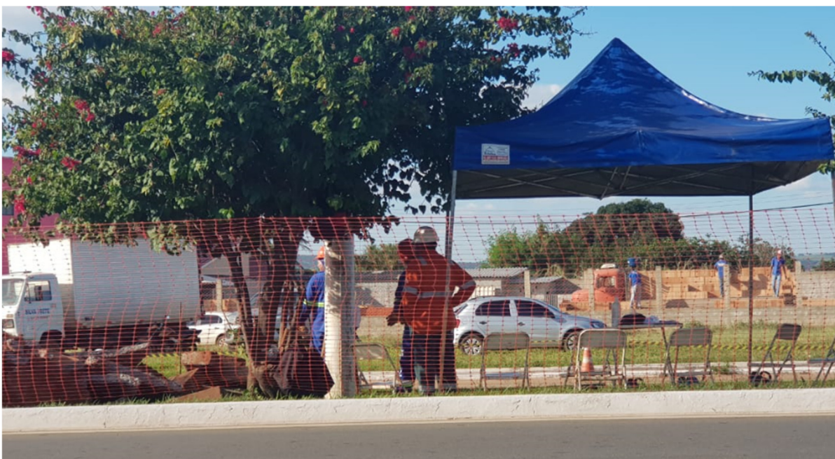
Figura 18: Operários trabalhando na manutenção do trecho Goiânia a Bonfinópolis.
