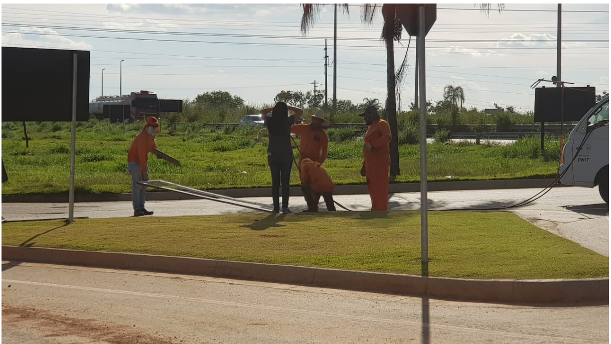
Figura 15: Operários pintando as faixas na via, trecho Goiânia a Bonfinópolis.
