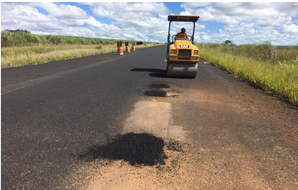
Figura 11: Operários tapando buracos na via, trecho Goiânia a Bonfinópolis.
