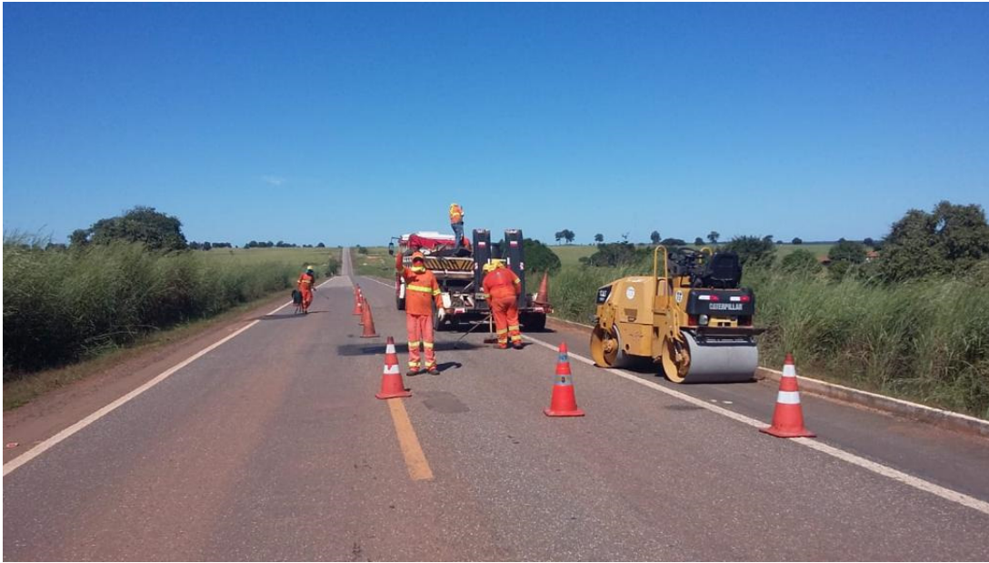
Figura 12: Operários tapando buracos na via, trecho Goiânia a Bonfinópolis.
