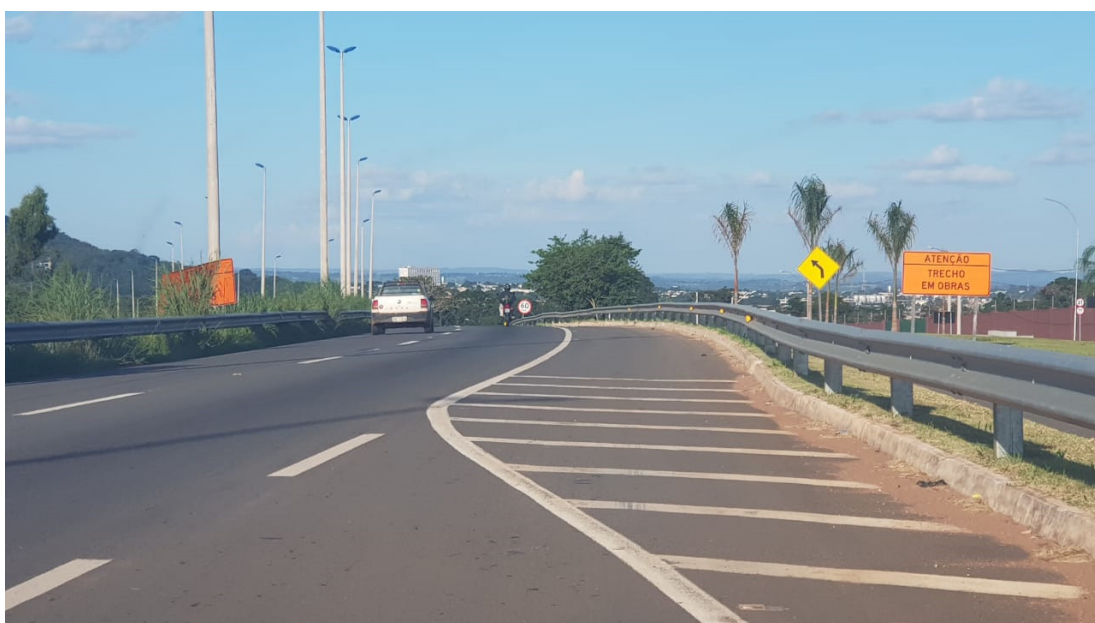
Figura 17: Sinalização para manutenção da via trecho Goiânia a Bonfinópolis.
