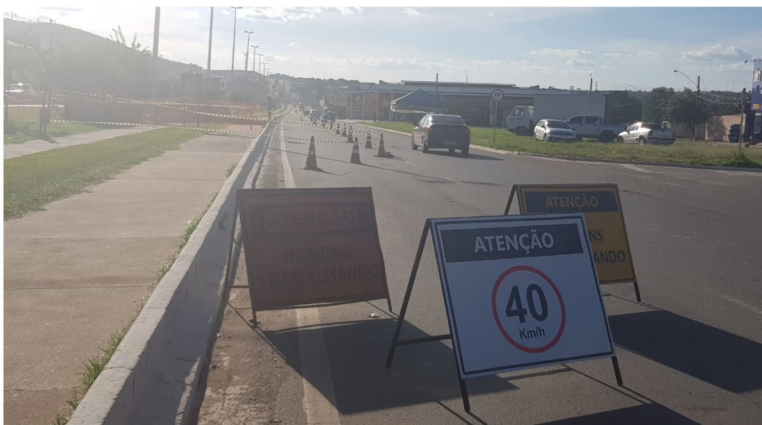
Figura 16: Sinalização para manutenção da via trecho Goiânia a Bonfinópolis.
