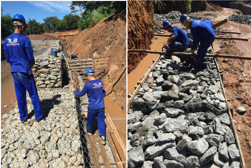
Figura 12. Preenchimento da última camada. Figura 13. Fechamento da tampa do gabião.
