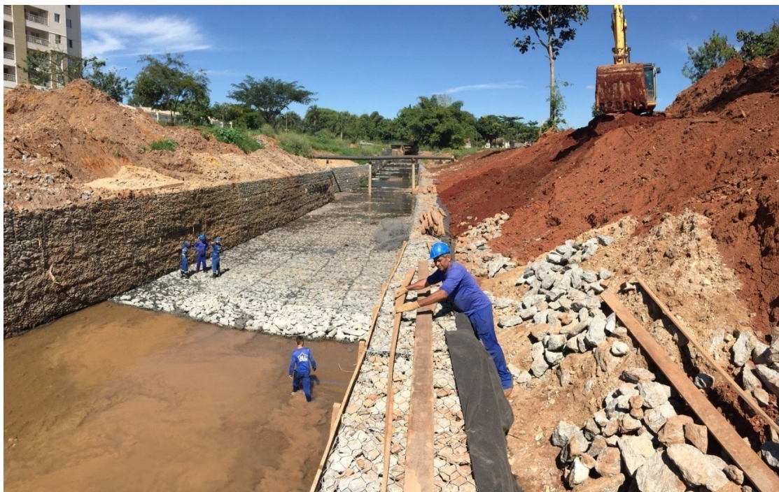
Figura 14: Operários e escavadeira hidráulica.
