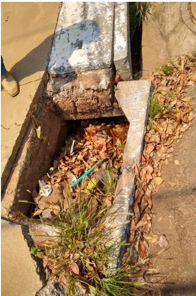
Figura 01. Boca de lobo obstruída na av. Guarapari.
