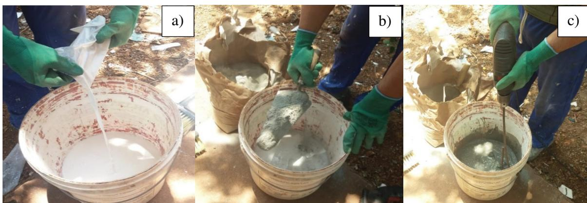
Figura 8. Preparação do impermeabilizante para aplicação; a) parte líquida; b) parte em pó; c) mistura dos componentes.
