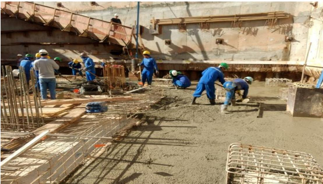
Figura 1 - Aplicação do concreto magro na Laje Subpressão.
