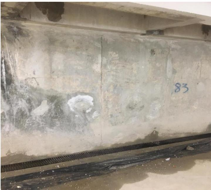
Figura 12 – Infiltração na laje.
