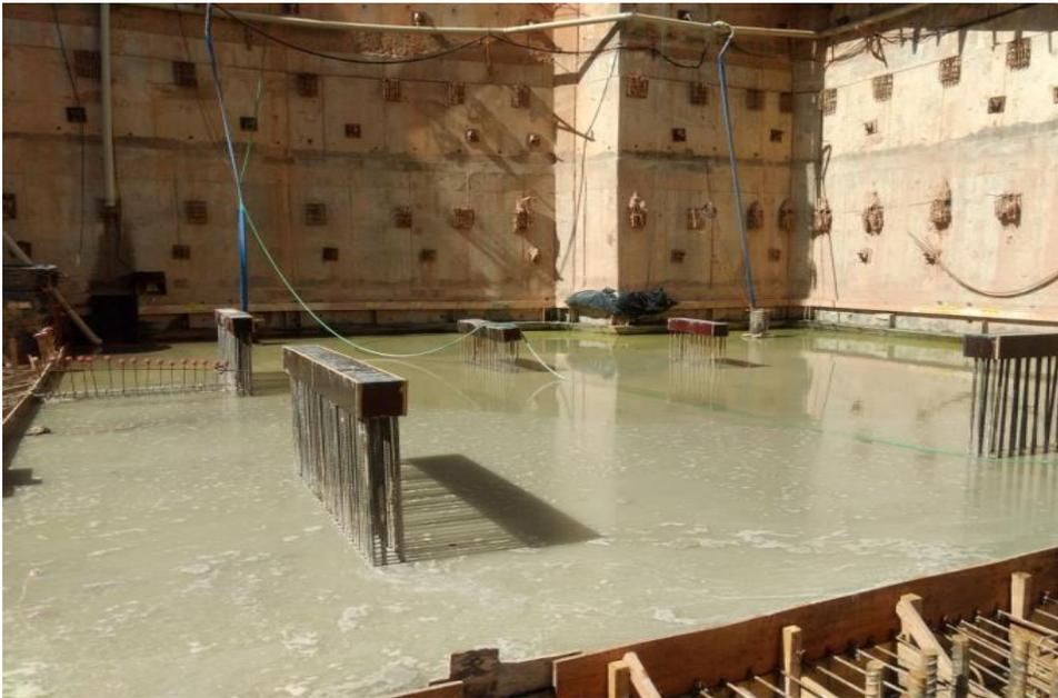
Figura 10 - Lâmina d'água sobre o concreto.
