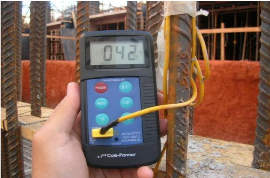
Figura 8 - Medição de temperatura com fios termopares.
