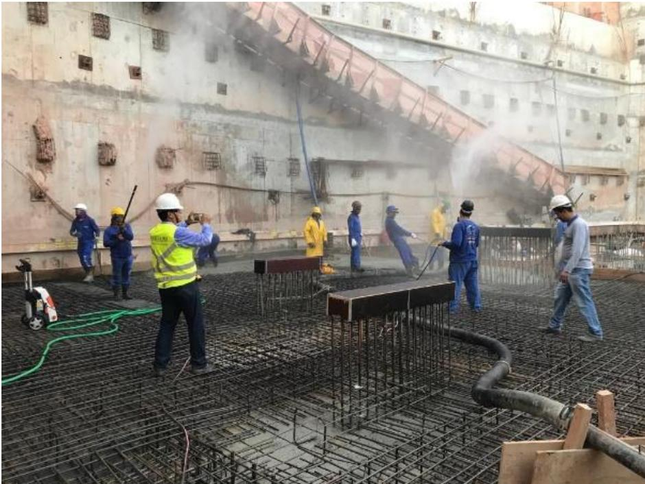
Figura 5 - Lançamento do concreto na Laje Subpressão.
