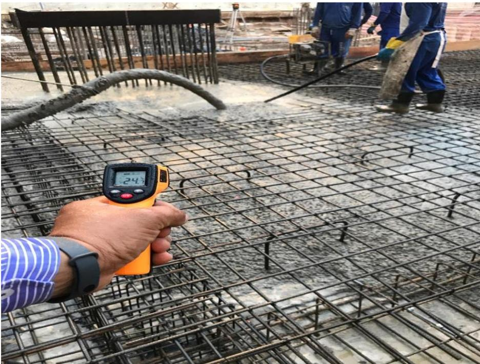
Figura 7 - Termômetro à laser.
