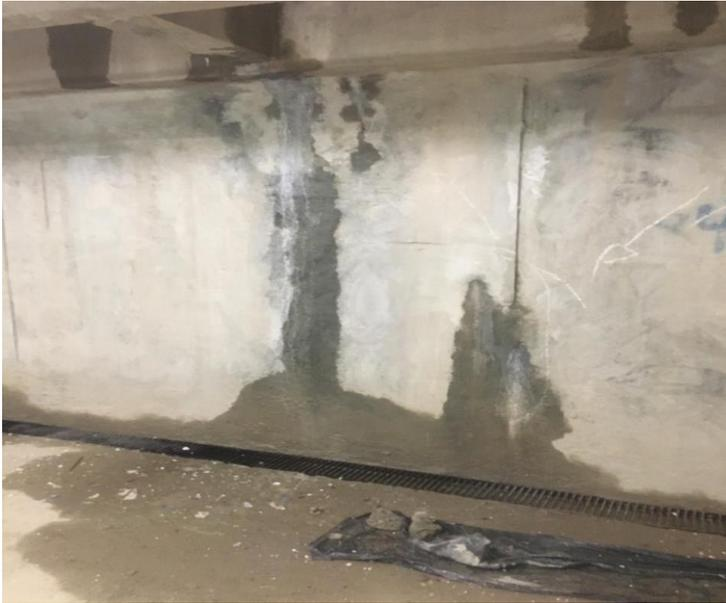
Figura 11 – Infiltração na cortina.
