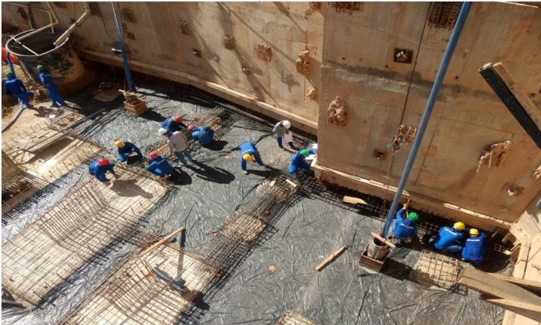
Figura 2 - Aplicação da lona plástica. Fonte: Grupo CF+ (2017).
