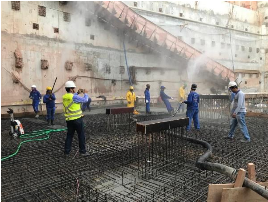
Figura 5 - Lançamento do concreto na Laje Subpressão. Fonte: Grupo CF+ (2017).
