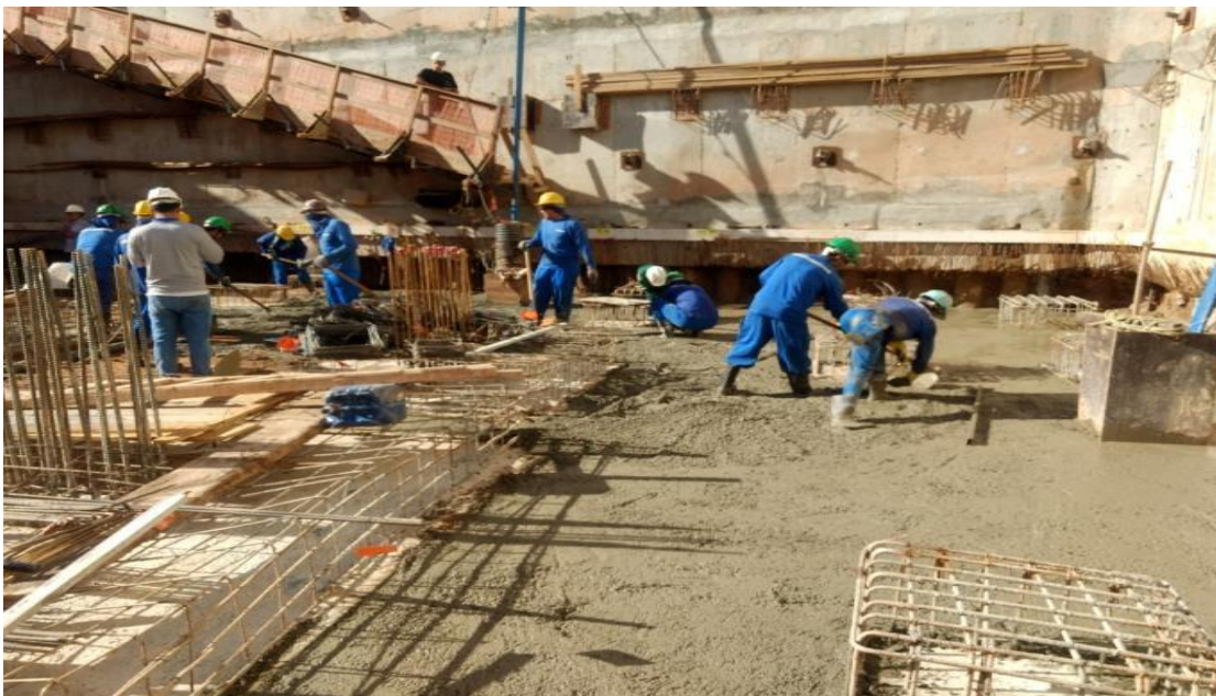
Figura 1 - Aplicação do concreto magro na Laje Subpressão.
