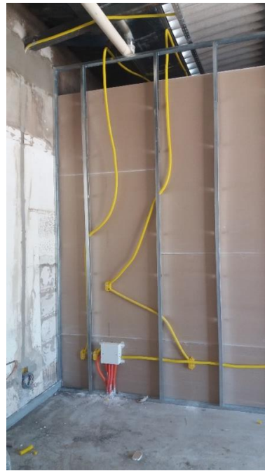
Figura 6: Instalação elétrica no vão do Drywall
