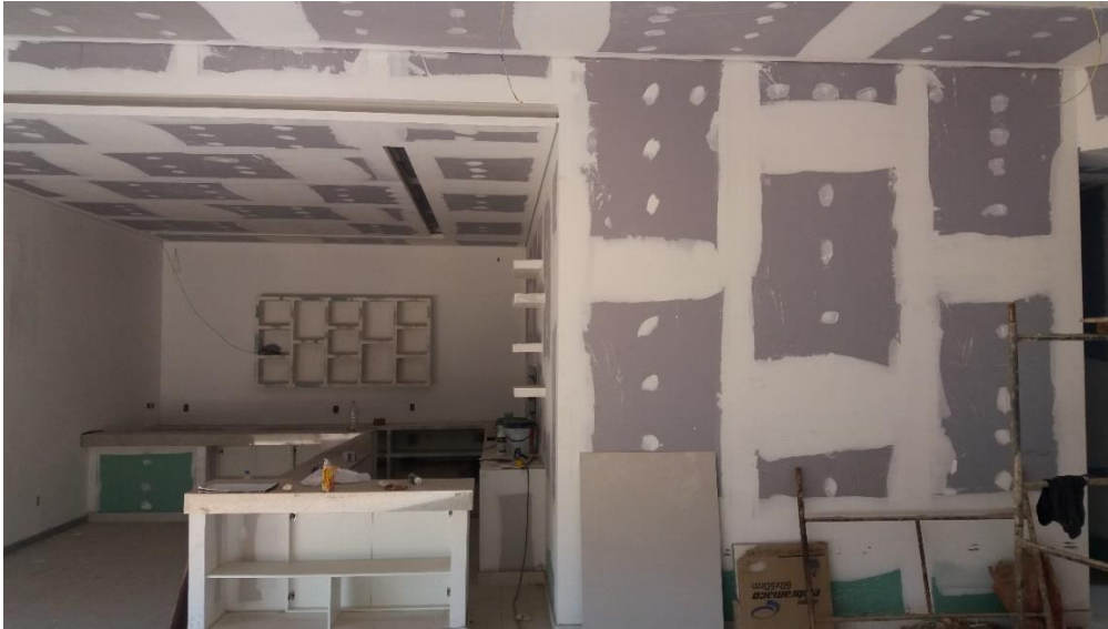
Figura 4: Parede construída em Drywall.
