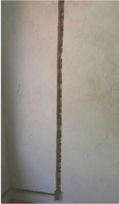
Figura 5: Rasgos para a instalação elétrica
