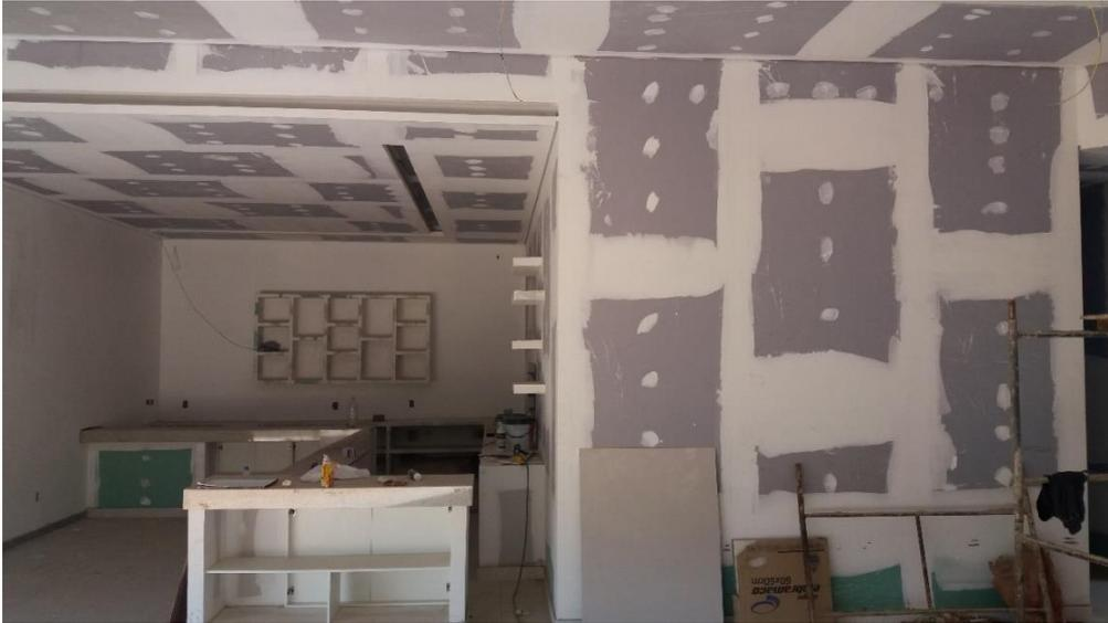
Figura 4: Parede construída em Drywall.
