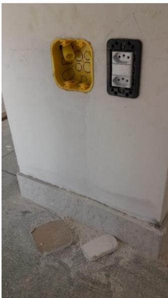
Figura 7: Resíduo gerado pela instalação elétrica nas parede de gesso acartonado.
