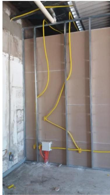
Figura 6: Instalação elétrica no vão do Drywall
