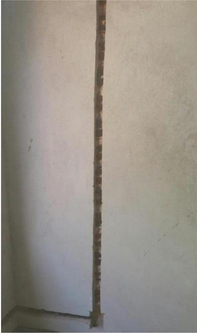
Figura 5: Rasgos para a instalação elétrica
