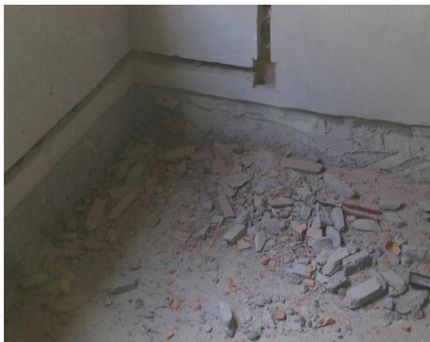
Figura 8: Resíduo gerado pela instalação elétrica nas paredes de tijolos cerâmicos.
