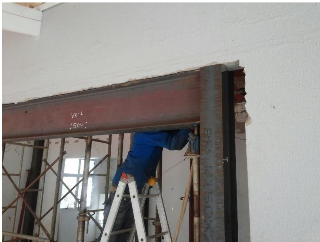
Figura 17: Colocação de Viga (macaqueamento).
