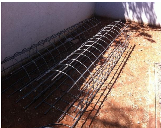
Figura 13: Armação da Fundação. Fonte: Autores
