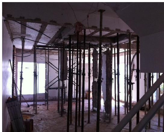
Figura 12: Alvenaria Removida. Fonte: Autores
