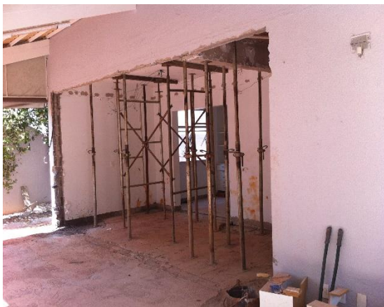
Figura 11: Remoção da Alvenaria. Fonte: Autores
