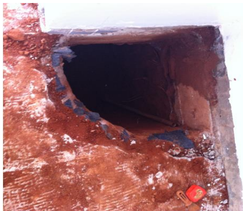
Figura 15: Fuste da Fundação. Fonte: Autores
