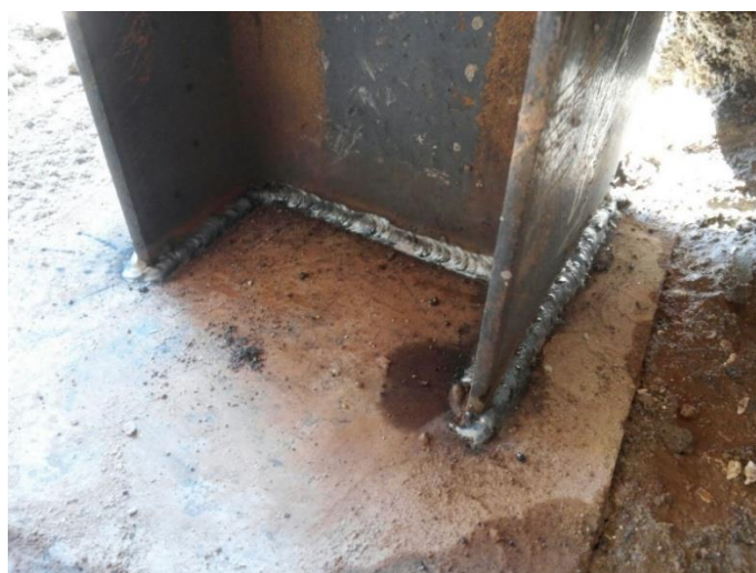
Figura 16: Pilar soldado no Coroamento (Chapa de Base).
