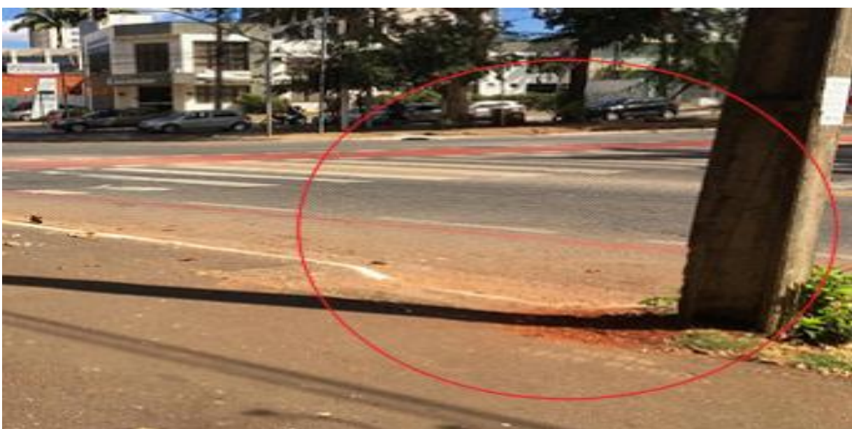
Figura 10: Rampa sem faixa de pedestre.
