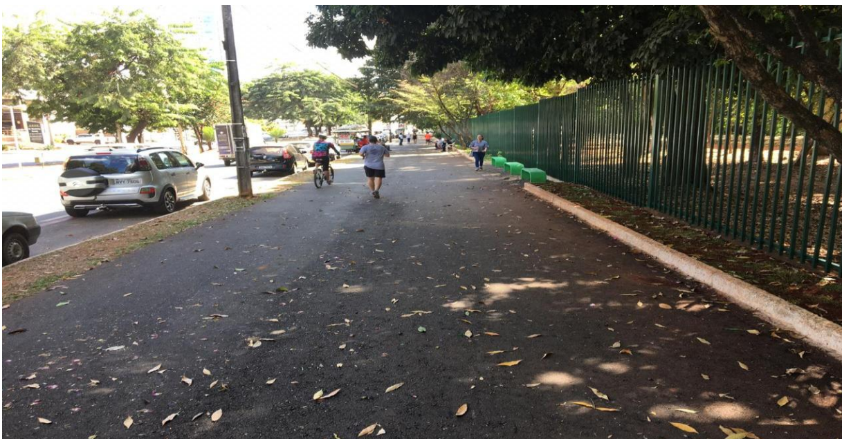
Figura 14: Falta do piso tátil.
