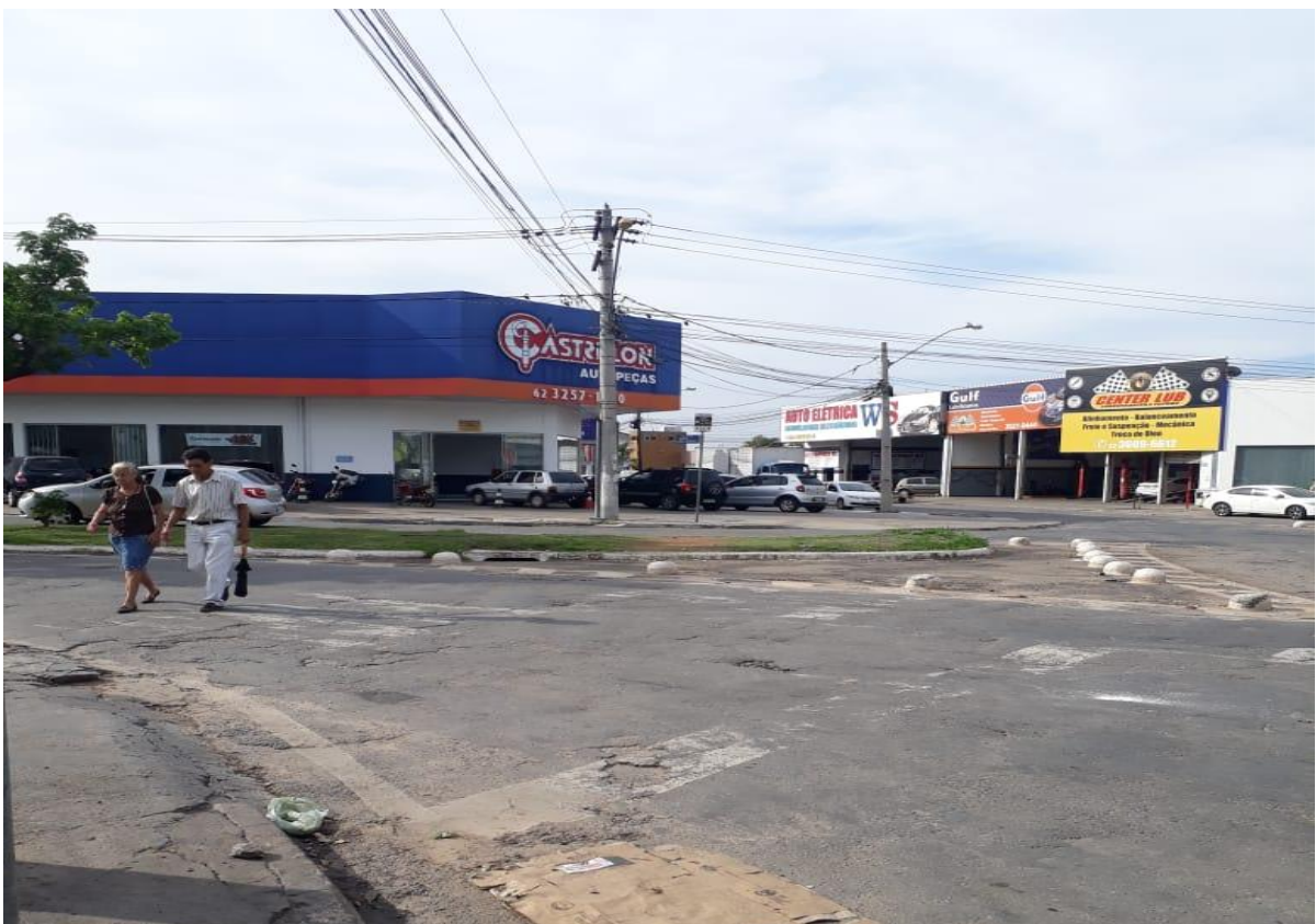
Figura 20. Sinalização horizontal apagada na Avenida Dom Emanuel
