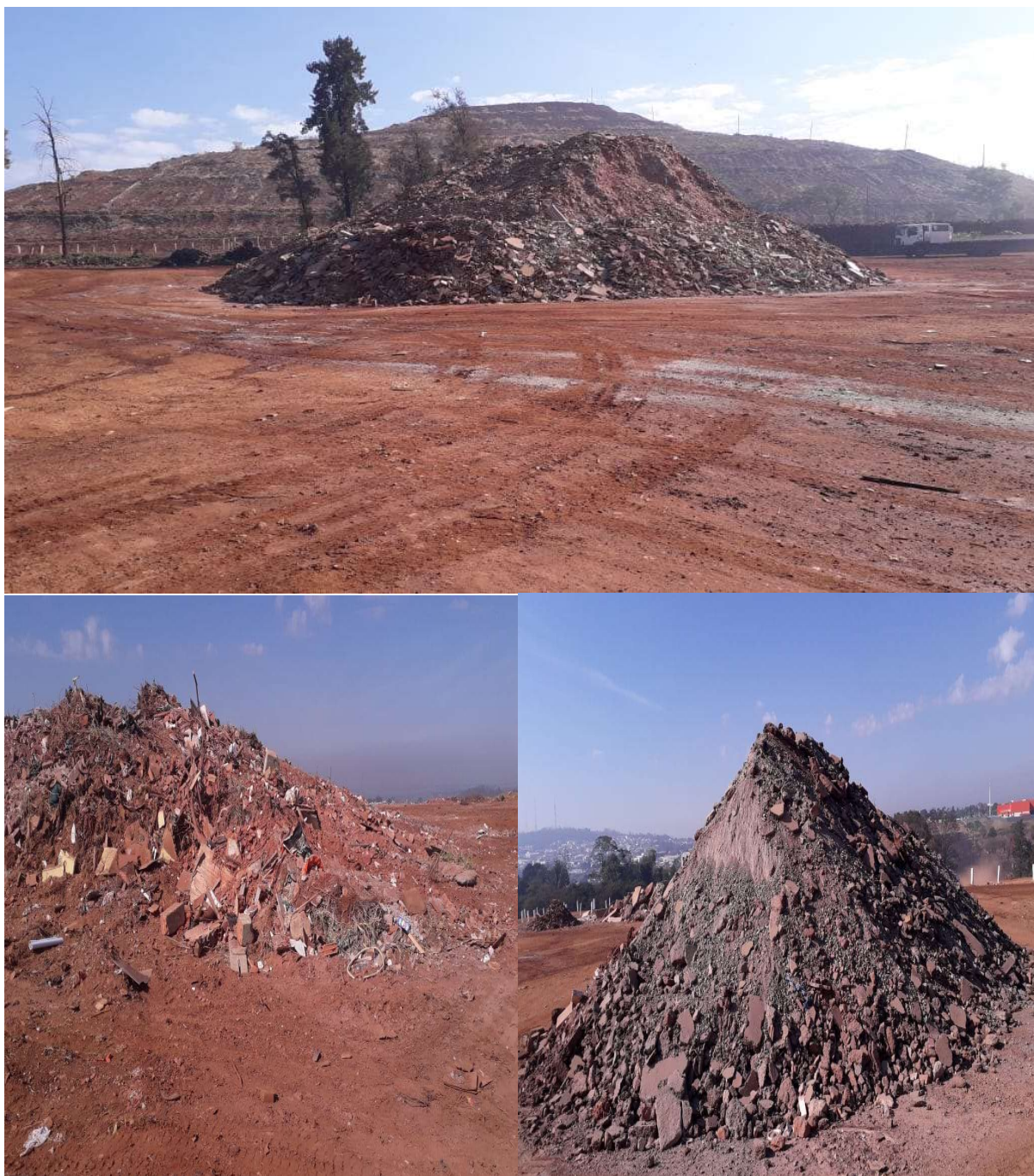
Figura B1. Aterro Sanitário.
