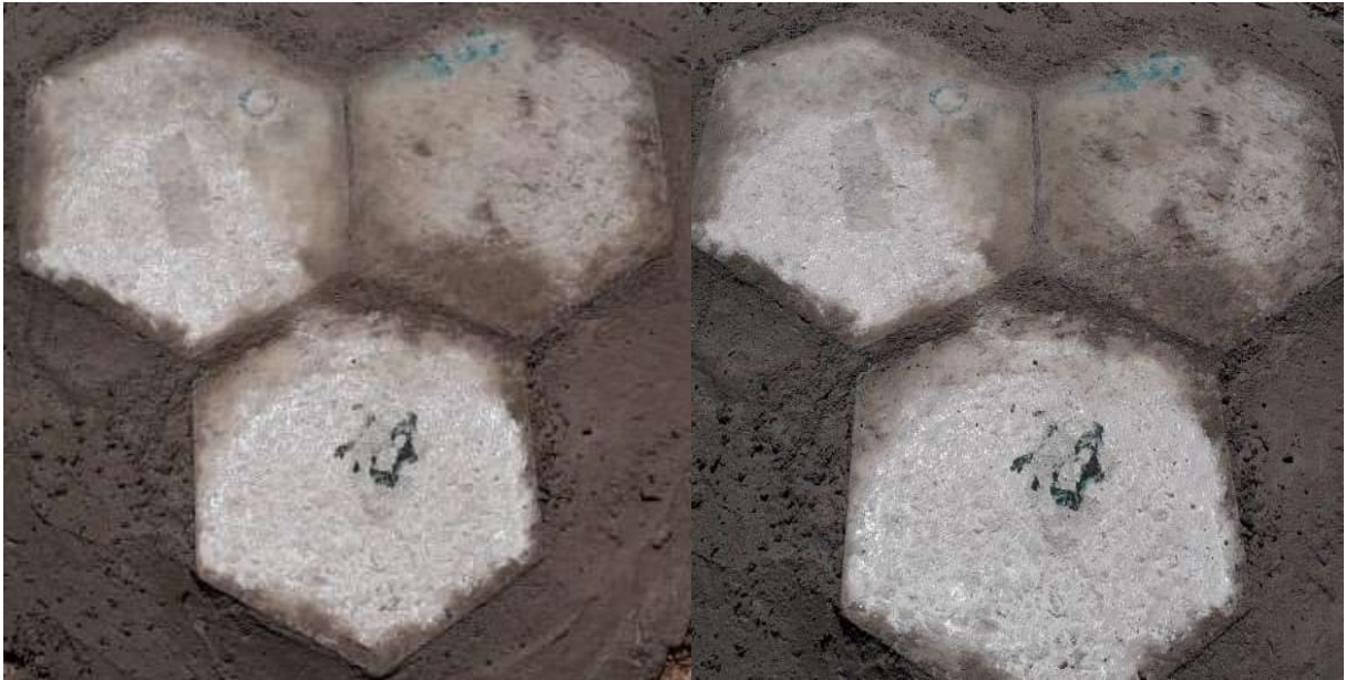
Figura 6. Inserção dos blocos na calçada.
