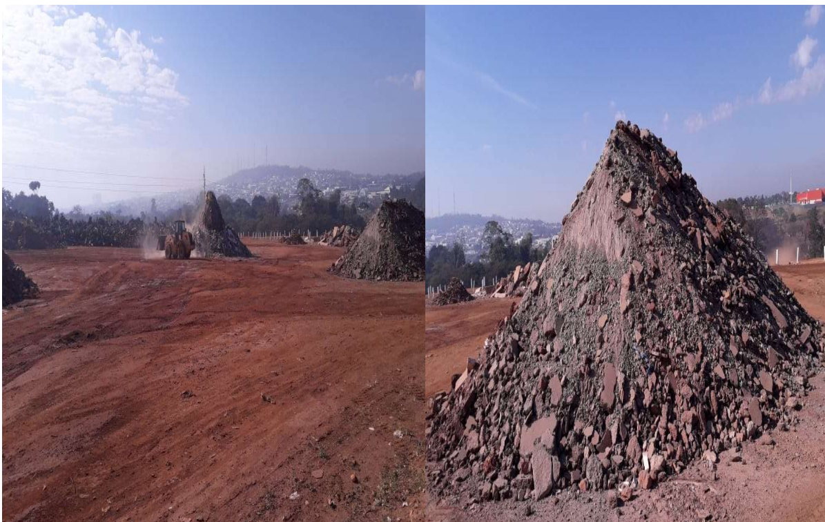
Figura G2. Local de descarte de RCC
