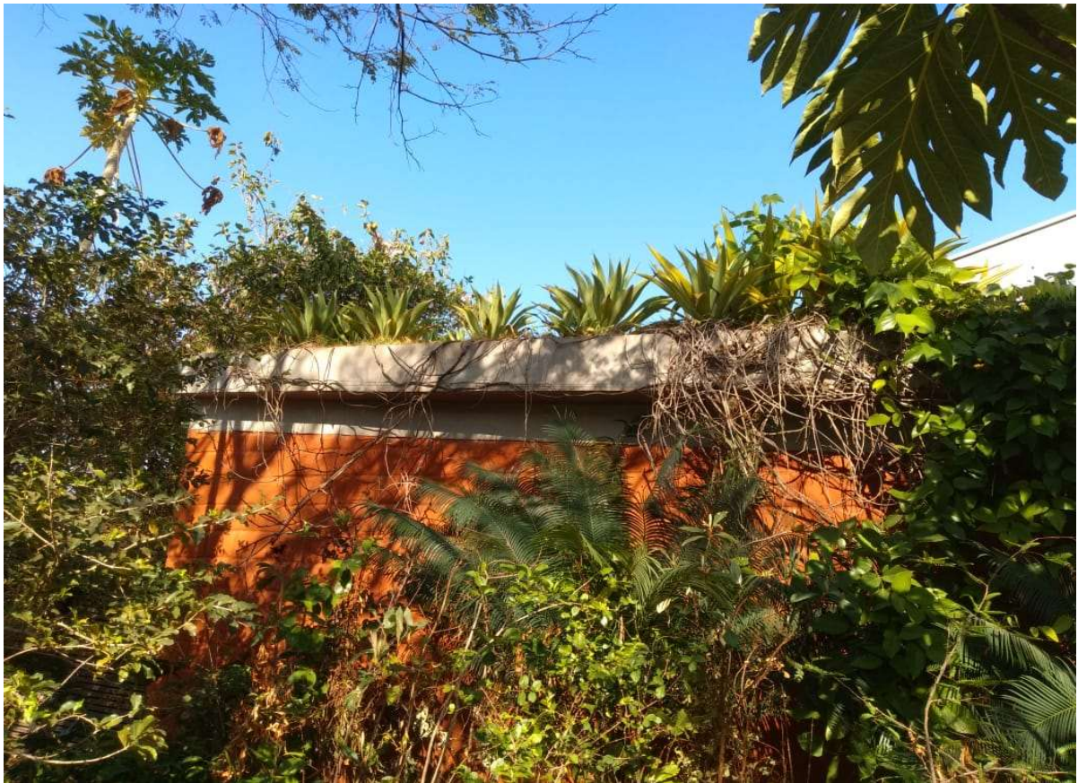
Figura 6: Parte Externa da Casa com Tijolo de Adobe.
