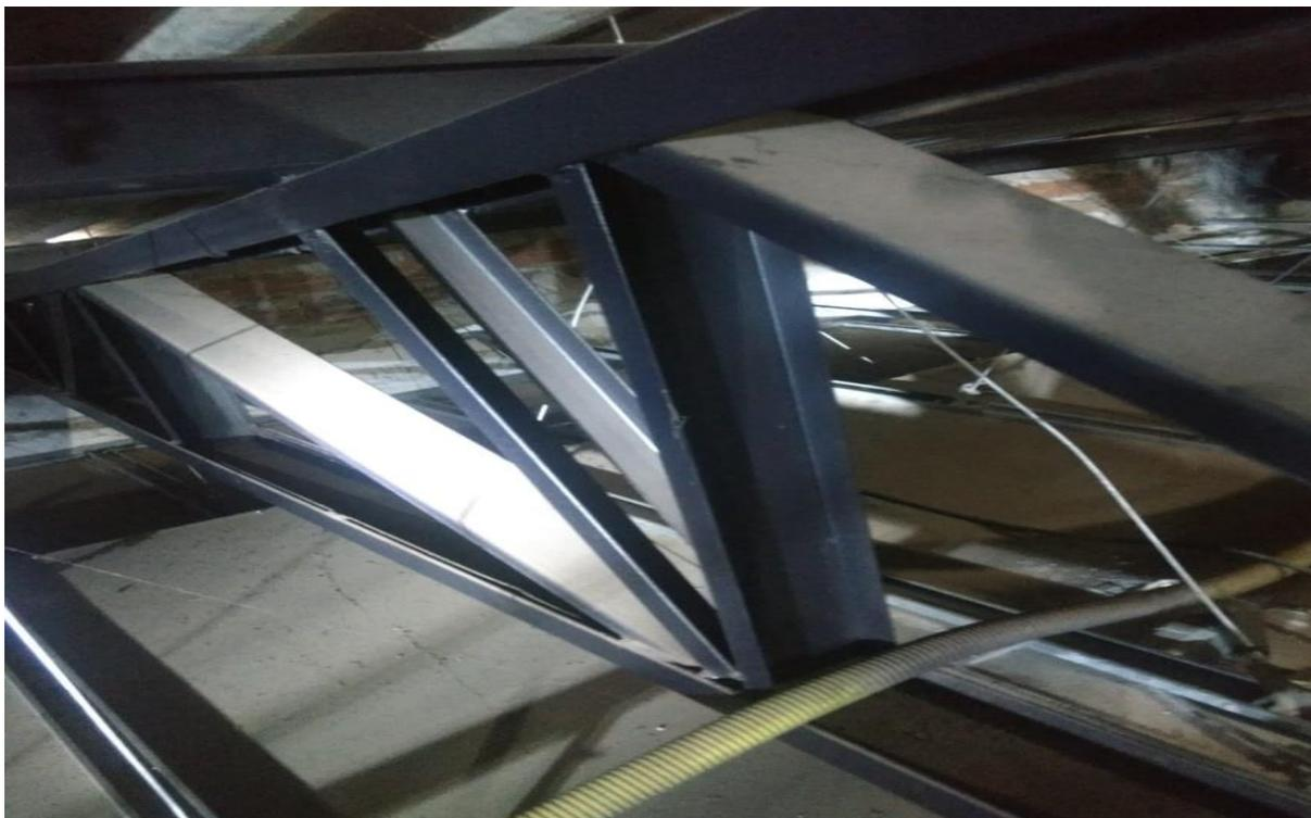
Figura 3: Tesoura original com reforço.
