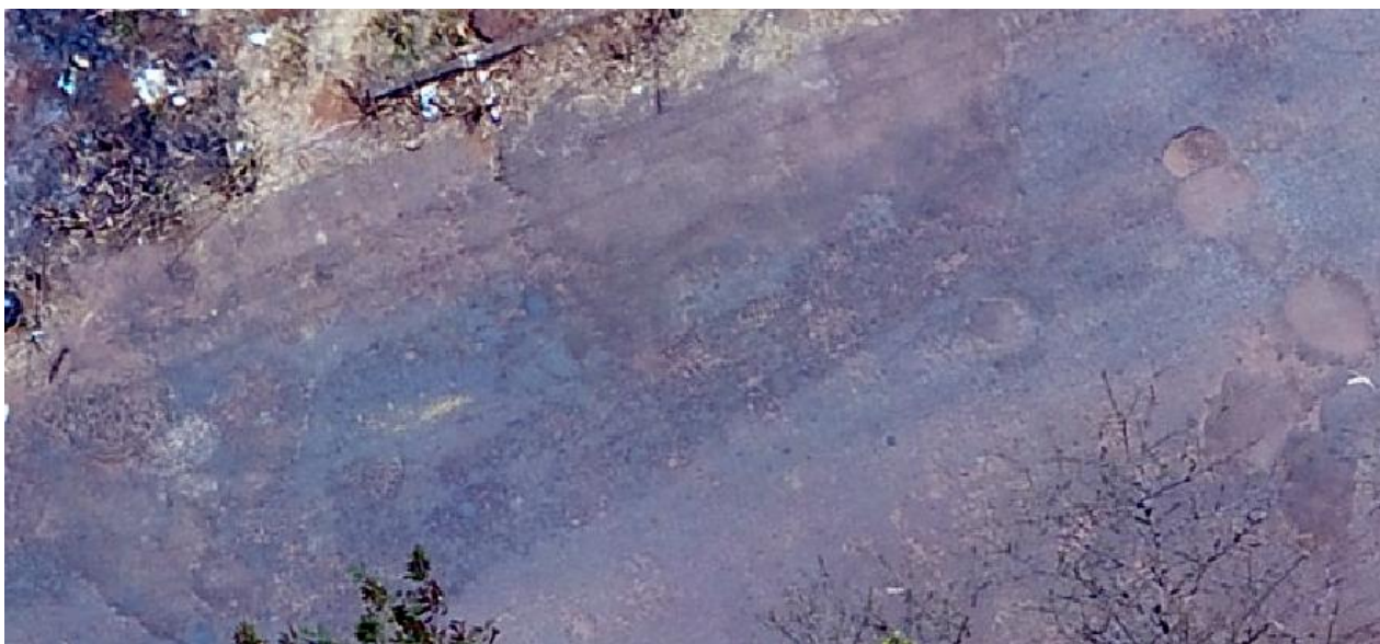
Figura 19. Patologia fissura e trinca na altura de 60 m.
