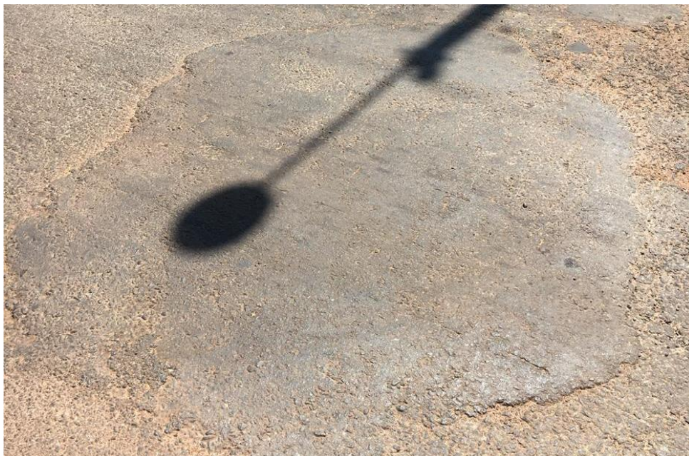
Figura 14. Patologia Remendo.
