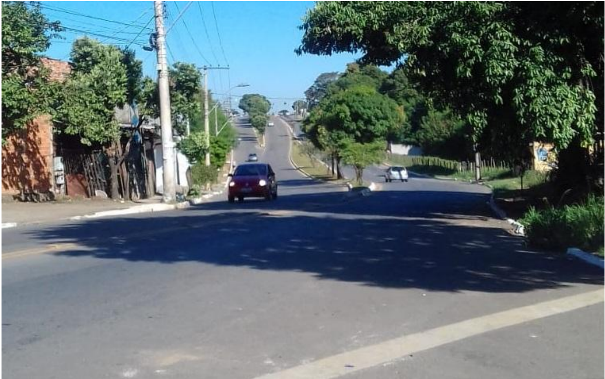
Figura 08 - Local onde se finalizará a ampliação da Avenida Leste Oeste, terminando na Rua da Alegria.
