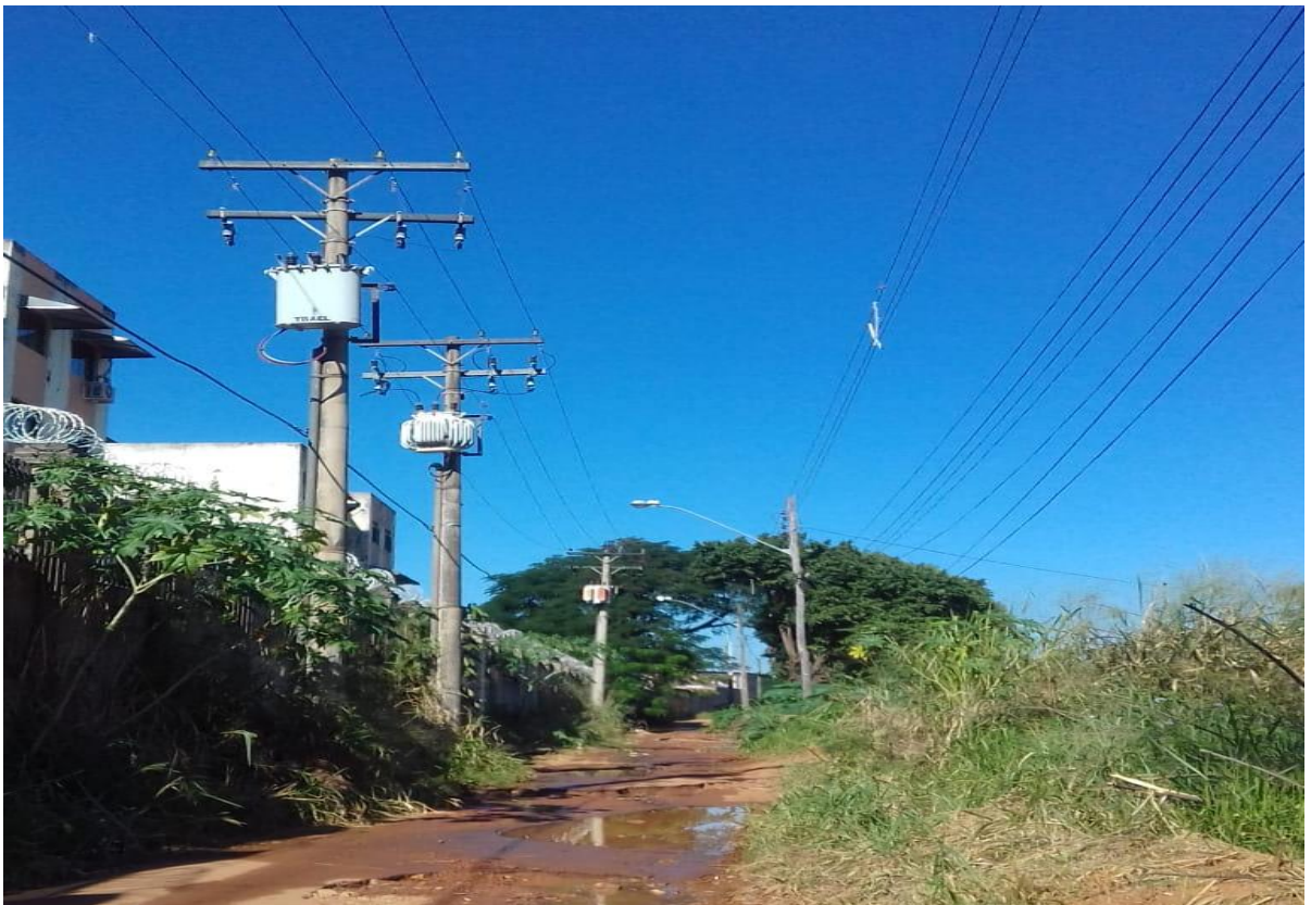
Figura 07 – Área no perímetro em que haverá a ampliação da Avenida.
