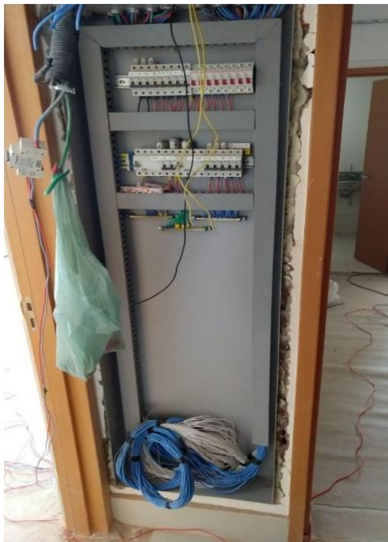
Figura 6. Demolição parcial de alvenaria para instalação do quadro técnico de automação.
