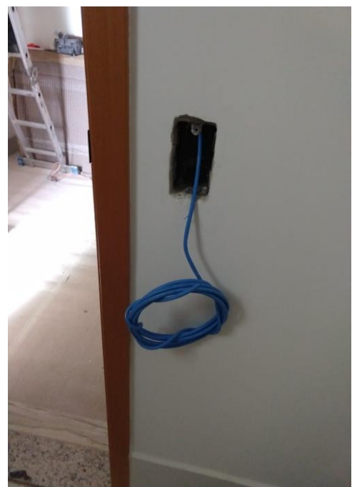
Figura 5. Reparo na alvenaria para instalação das caixas de passagem.
