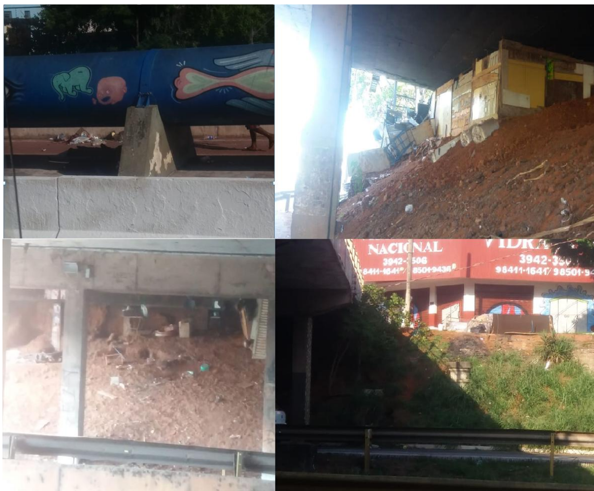
Figura 13: Indícios de pessoas em situação de rua em trechos da Marginal Botafogo. Fonte: O autor
