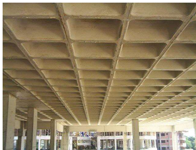
Figura 09 – Laje nervurada.
