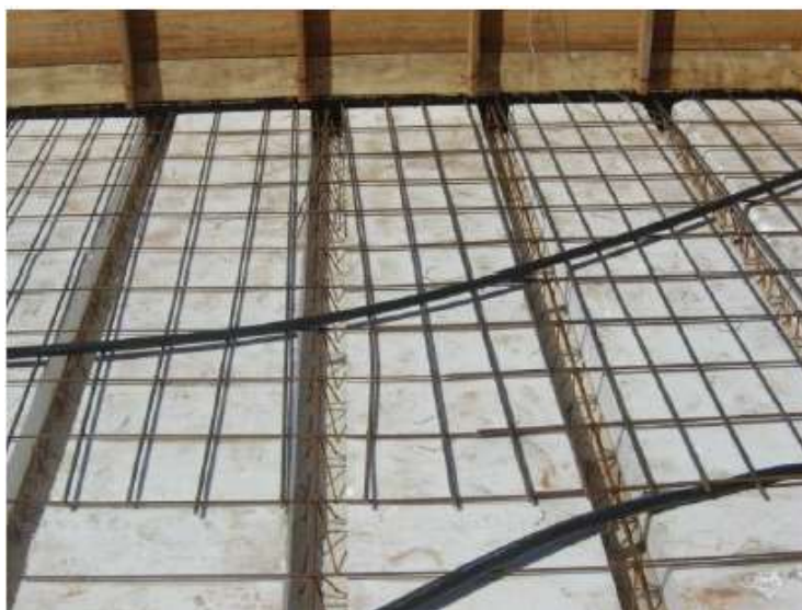
Figura10 – Laje Pré – fabricada (Treliçada)
