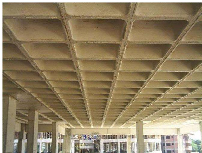
Figura 09 – Laje nervurada.
