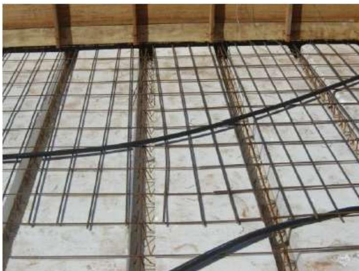
Figura10 – Laje Pré – fabricada (Treliçada)
