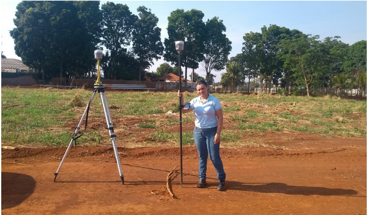
Figura 02. Levantamento topográfico com RTK.
