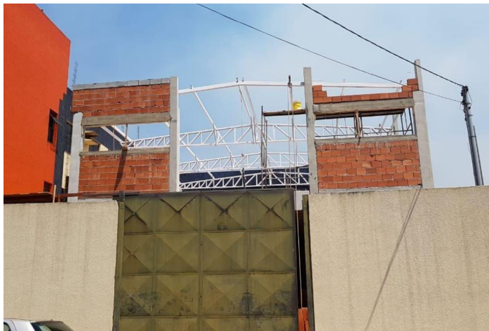
Figura 1. Estrutura galpão industrial localizado em Goiânia.
