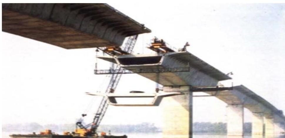
Figura 1. Ponte protendida em balanços sucessivos
