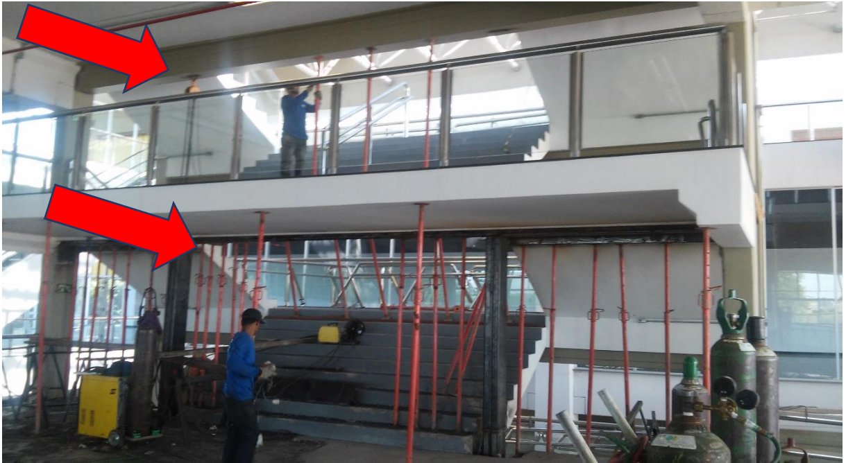
Figura 07. Escoramento da viga para ser feito o corte. Fonte: Eduardo Mariano (2016)
