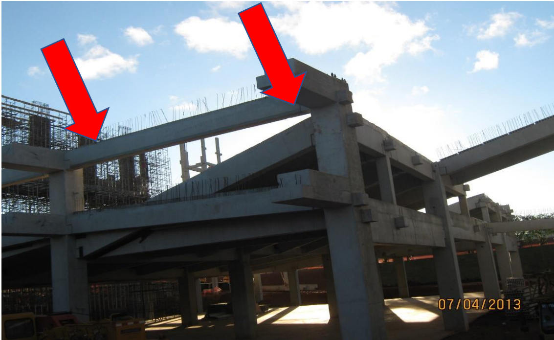
Figura 5. Altura variando em um mesmo pavimento. Fonte: Eduardo Mariano Cavalcante de Castro (2013).
