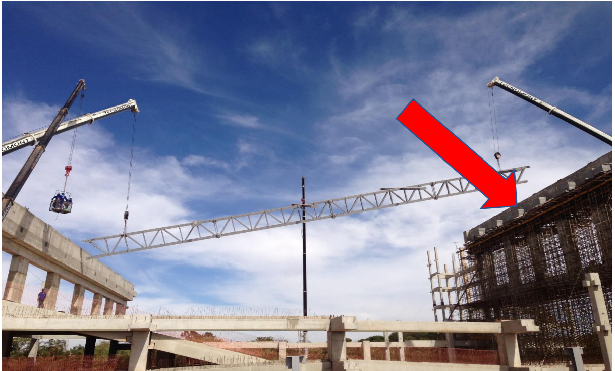
Figura 06. Viga Vierendeel com escoramento. Fonte: Eduardo Mariano (2013)
