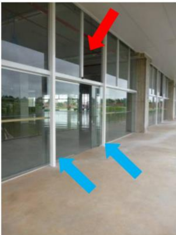
Figura 15. Cortina fachada parcialmente reparada (seta vermelha ausência de vidro) e reparada (pilar metálico instalado).
